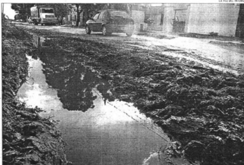
En el sur de Coronel Moldes los pozos colapsan y el agua servida sale a la cuneta.
