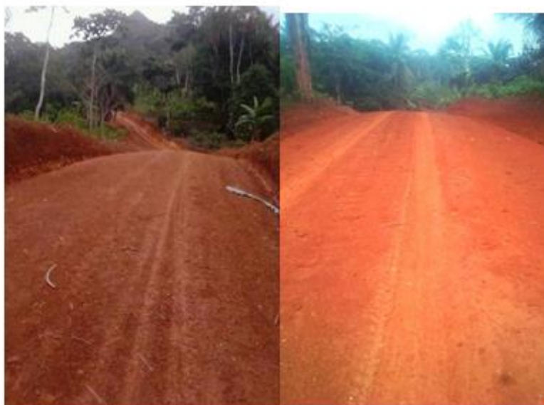
Figure 2 : construction d'une route
