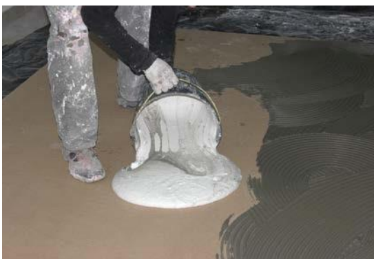
Fig.16 - colocação da argamassa
