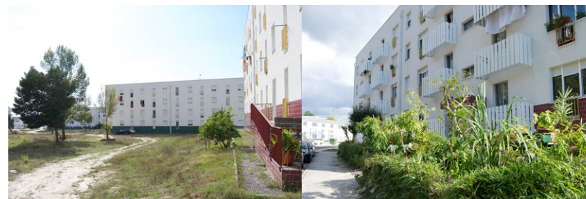
Fig. 57 e 58 Vista exterior do bairro Francisco Sá Carneiro | Marrazes | 2014
