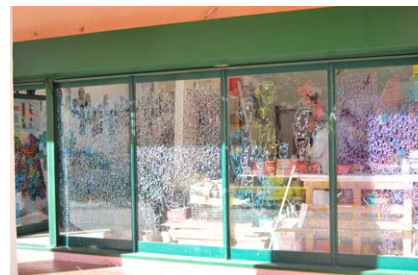
Fig. 12 Oficina do reMix | Exterior | Bairro do Armador | 2014
