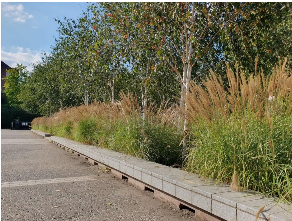
Bilde 44. Ensidig fall på overflaten sørget for at vannet har fri passasje gjennom slisser i regnbedkanten.
