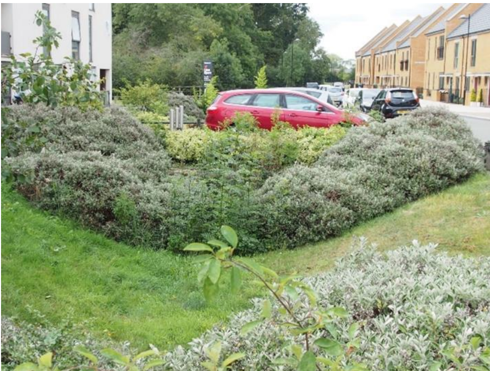
Bilde 11. Vadi/regnbed langs vei i boligstrøk med opparbeidet vegetasjon.
