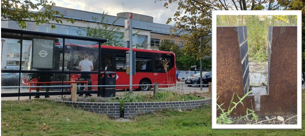
Bilde 47. Mottagende regnbed har en åpning på nedsiden som avleder vannet videre i en vadi.
