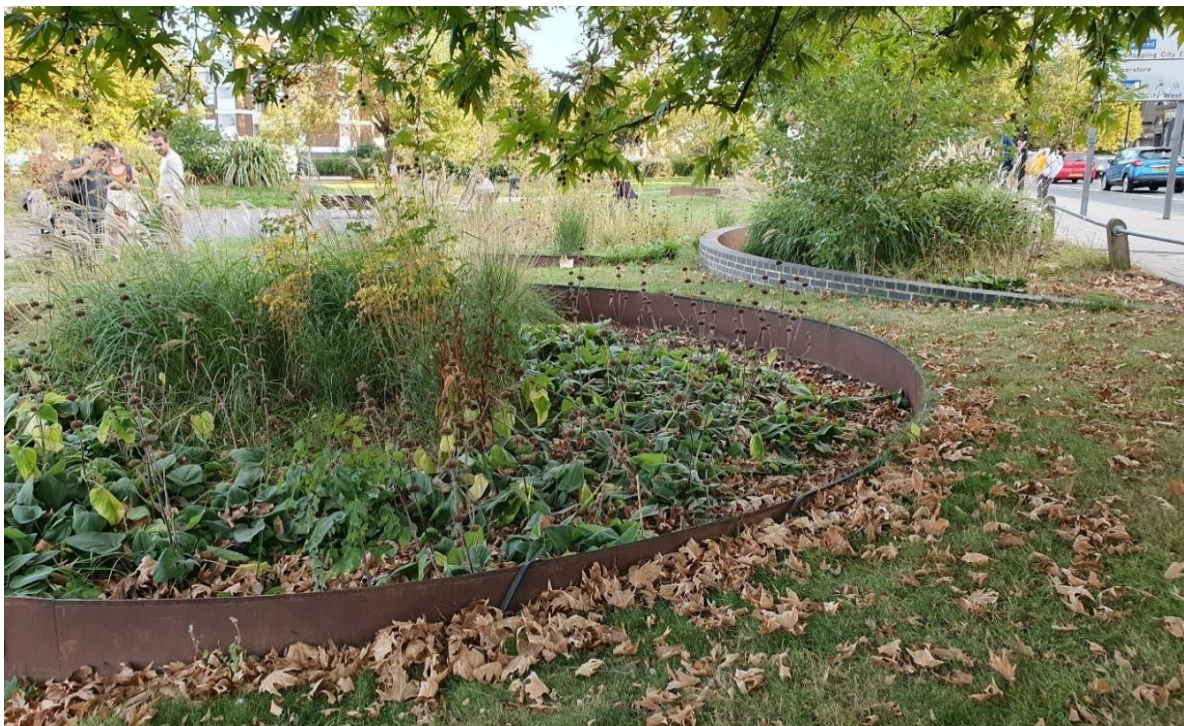
Bilde 48. Flere regnbed i ringer og halvsirkler utgjør en fin estetisk samling av regnbed i nærheten av en trafikkert gate i London. Vann fra fortau ledes direkte i regnbedene og parken for øvrig, mens vann fra gaten ledes til regnbedene i lukkede renner.
