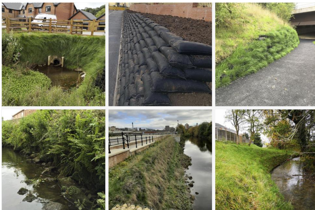
Bilde 6. Sekker stables på en spesiell måte, og tilsås. Vann og røtter kan trenge igjennom sekkene. Til sammen dannes en stabil og naturlig utseende skråning som kan stå ganske bratt (bilder fra GeoGrows hjemmeside) og kan stå imot erosjon i utsatte partier (f.eks. sving og kulvertinntak) i et vassdrag, ved dammer, eller ved dype overvannsløsninger.
