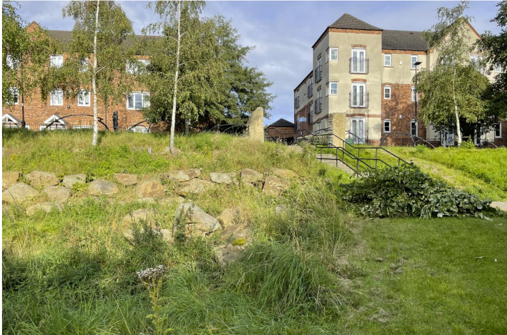
Bilde 37. Overvann fra tette flater ledes i rør til et våtmarkssystem i Manor fields parken.
