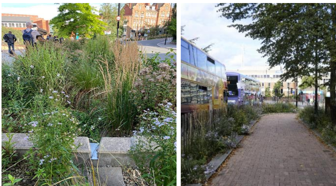
Bilde 35. Angel Street. Et eksempel på regnbed ved siden av sykkelstien på den skrånende gata. Det er en utfordring med design av innløpet slik av overvannet renner inn i anlegget.
