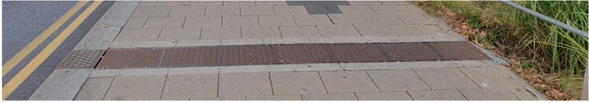
Bilde 46. Vannet ledes fra gaten i renner til parken hvor det først havner i et regnbed, og deretter via en åpning kan renne videre i en vadi til flere regnbed og til selve gressarealet.
