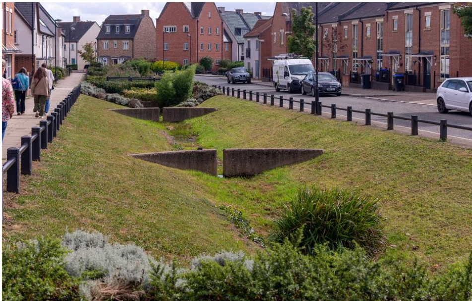
Bilde 8. Lokal overvannsdiskonering innpasset i et boligstrøk i Upton.
