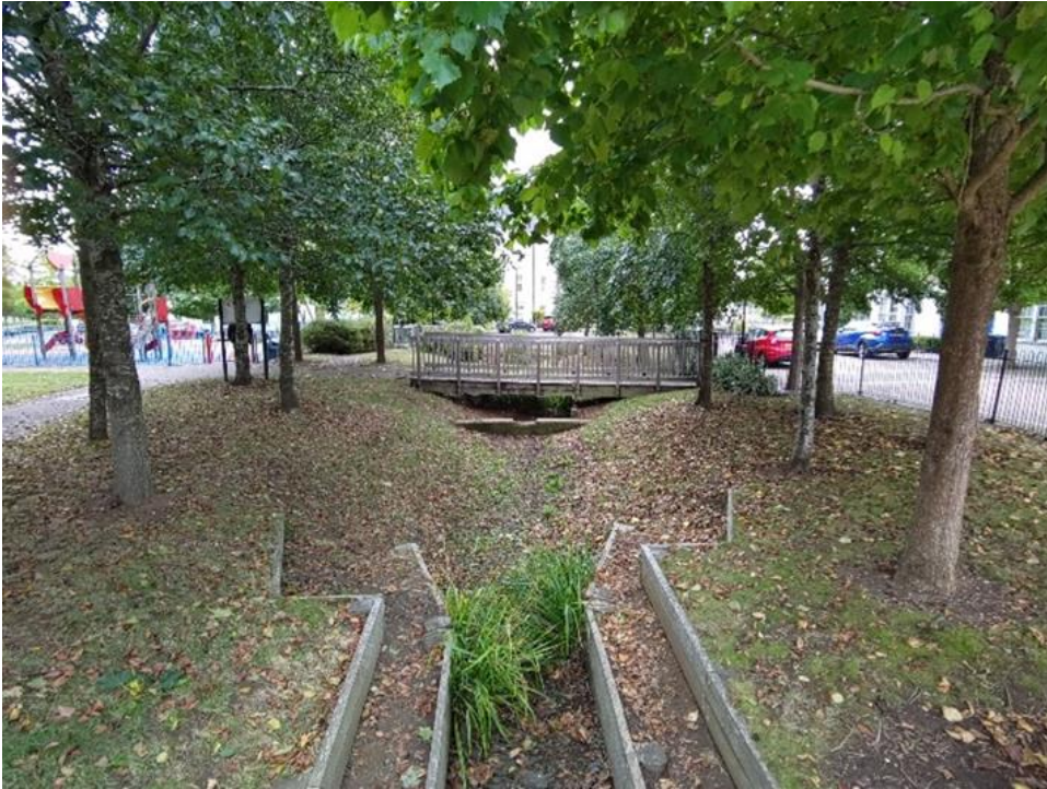
Bilde 10. Vadi som leder vann fra boliger gjennom en lekeplass for filtrering i et offentlig grøntområde.
