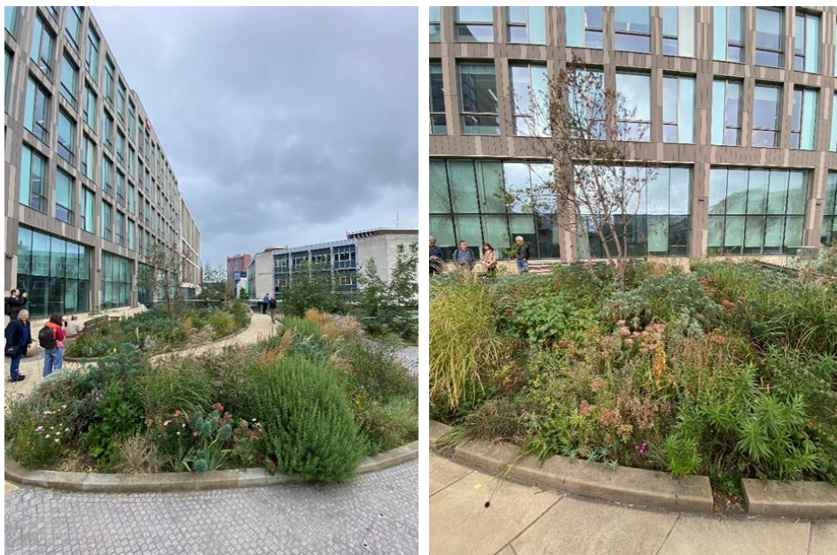
Bilde 34. Charter Square er et eksempel på en kombinasjon av forskjellige SUDS for å skape et regnvannshåndteringsanlegg, slik som: blått tak (på hovedbygningen – 2400 m 2 og stor takterrasse 180 m 2 ), grønt tak (450 m 2 ), terrasserte bioretensjonshager med 4 m nivåforskjell og LOD-elementer lagt inn langs gateløpet ( sheffield_charter_square_2020_awards.pdf ( susdrain.org ))
