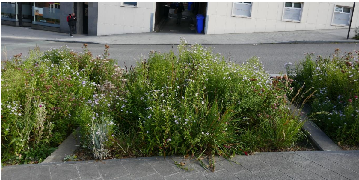
Bilde 26. Terrasserte regnbud som kan samle en del vann i hvert av feltene før det renner over til neste via en slisse i betongveggen, synlig på høyre side.
