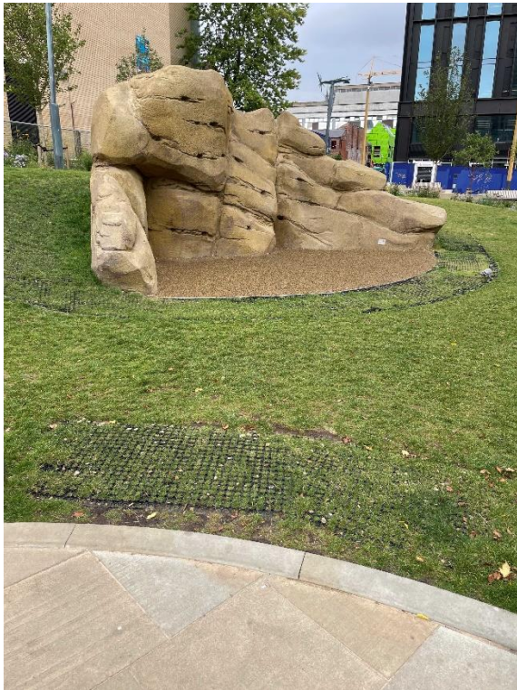
Bilde 32. Forsterking av gresset ved klatrefjellet (venstre). Overvannet ble tatt vare på igjennom anlegget, og noe ble lagret i magasin under jorda som muliggjorde pumping og lek med vann (høyre) - en mulighet ekskursjonsdeltakerne ikke lot gå fra seg. Anlegget er et godt eksempel på at overvannet kan benyttes som en ressurs, gjøres synlig i byrommet og bidra til aktivitet.
