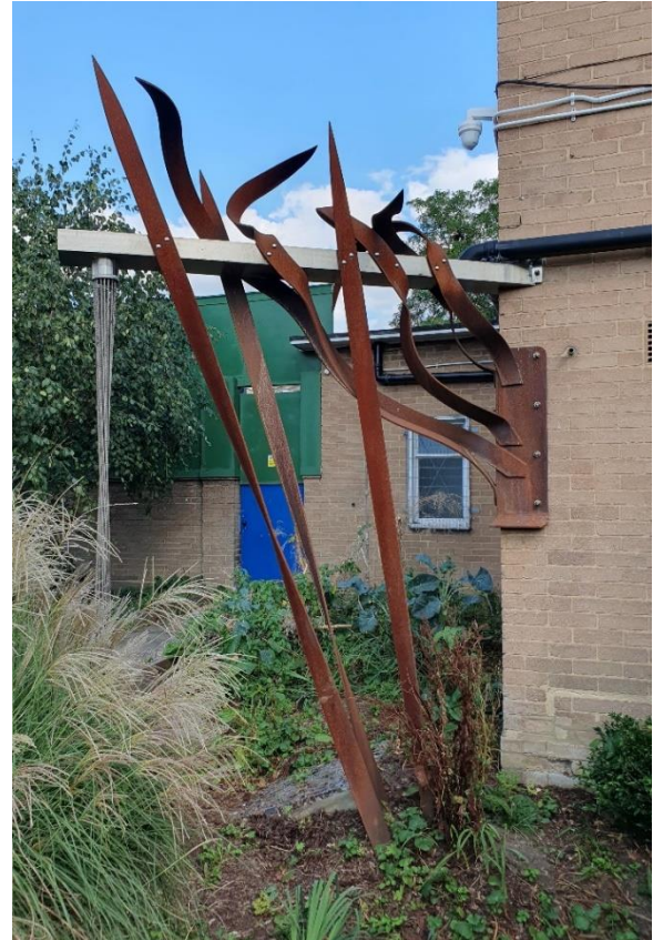
Bilde 43. Kevin Barton fra Robert Bray Associates, viste oss rundt. Takvannet ble ledet gjennom en kunstnerisk utformet renne og ned i et regnbed via ståltråder - en attraksjon i seg selv som vi fikk fortalt at skolebarna tok med foreldrene for å se på når det regner.
