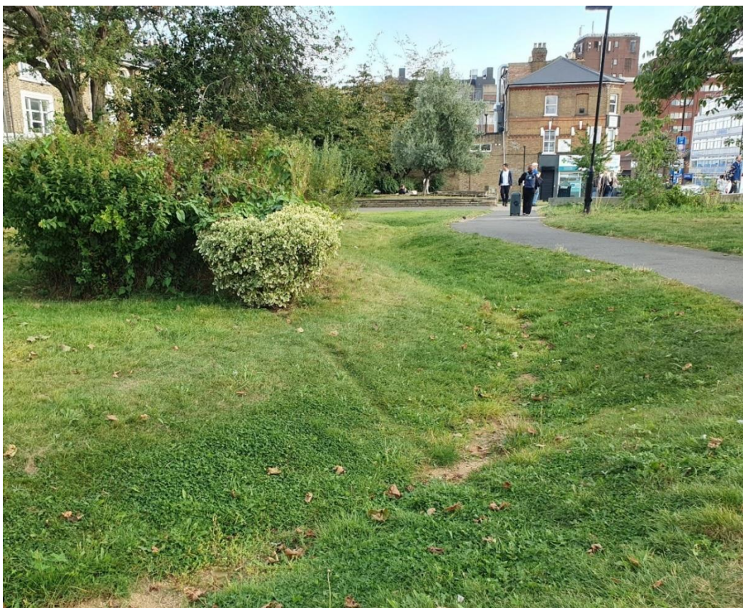
Bilde 49. En vadi er et sentralt element i bunnen av parken, som både fordøyer og leder vannet mellom regnbedene.
