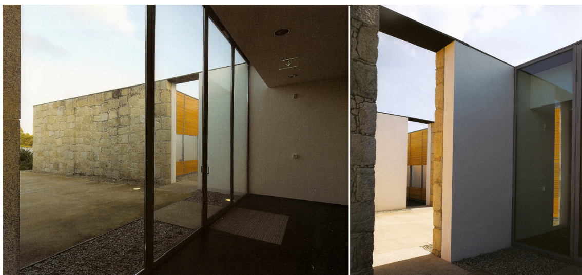
33. Entrada do edifício.
