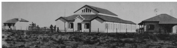
Figura 2: Escuela rural de 10 aulas
