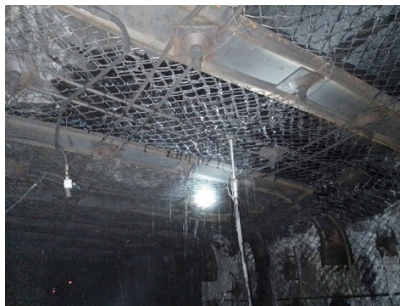
图 13 现场注浆过程
