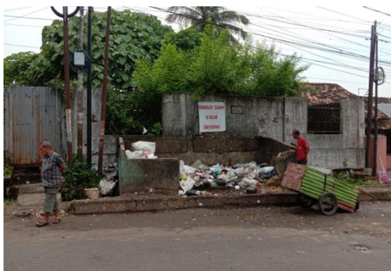
Gambar 9. Kondisi Pedestrian yang tertutup area TPS (Sumber : Dokumentasi Pribadi, 2023)
