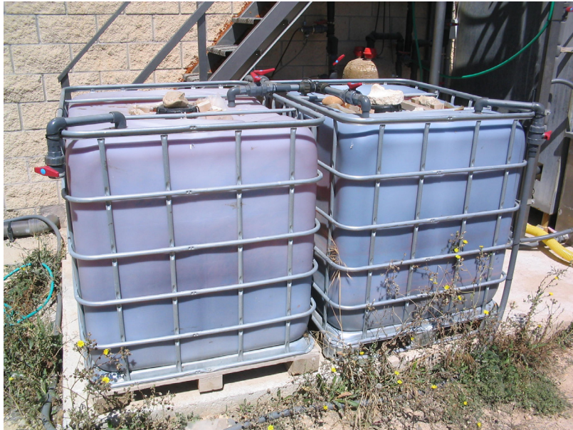
Fotografía 6-14. Depósitos para almacenamiento de sangre concentrada y diluida
