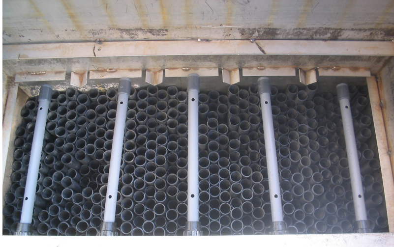
Fotografía 6-4. Distribuidores superiores y pletinas metálicas de sujeción de las campanas
