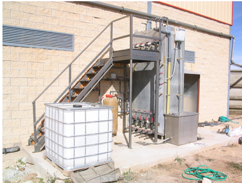
Fotografía 6-2. Vista general BAPF piloto Abadesa
