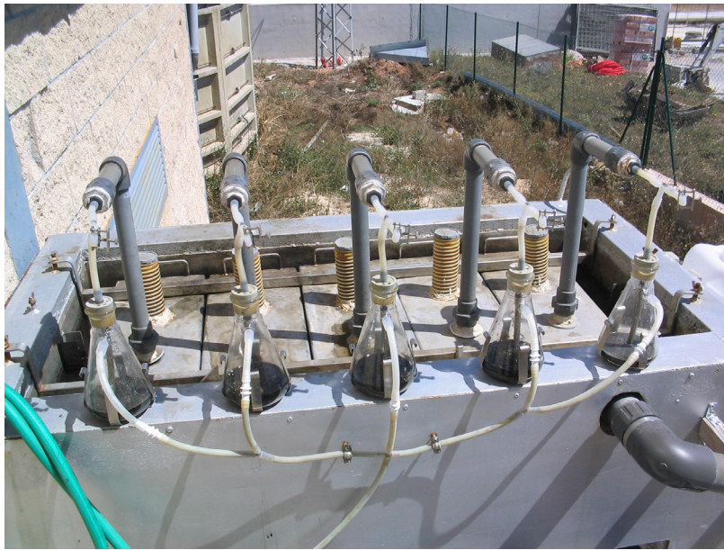
Fotografía 6-8. Sistema de recogida de biogás reformado
