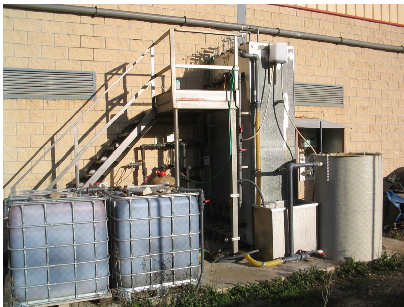
Fotografía 8-4. Vista global de la planta piloto
