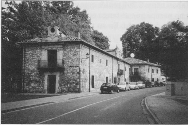
Aspecto actual de la casa-residencia del esquila y lavadero de lanas de los Thomé
