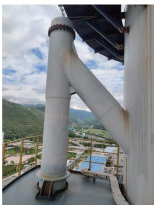
图6 现场缓冲管和管帽的实物
