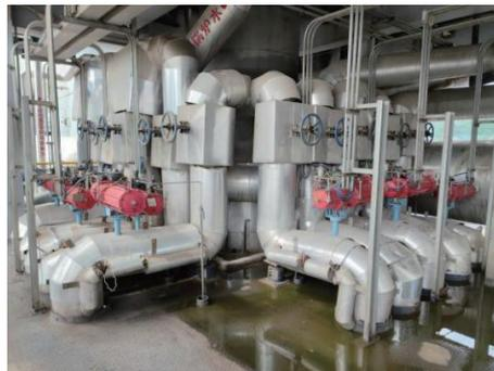
图11 余热锅炉蒸汽吹灰管口现场实物
