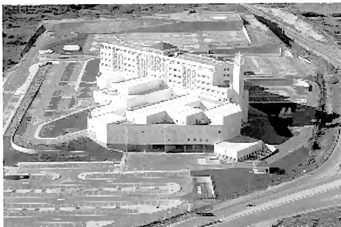
Figura 3.1. Imagem do Actual Hospital do Barlavento Algarvio
