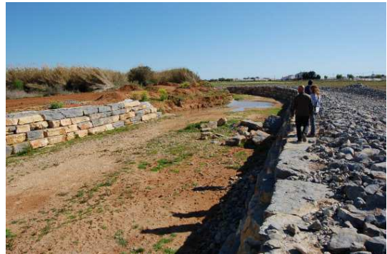
Figura 5.9 - - Troço a jusante da EN125. (Santos, 2012)
