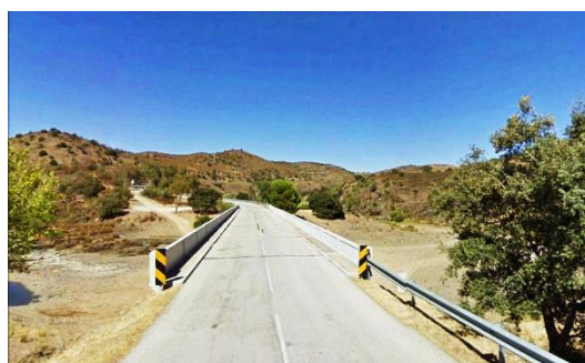
Fig. 35 - Ponte da Ribeira da Foupana (Agosto de 2009)
