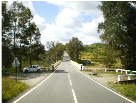
Fig. 22 – Áreas de Repouso da Ponte Dois Irmãos (Abril de 2014)
