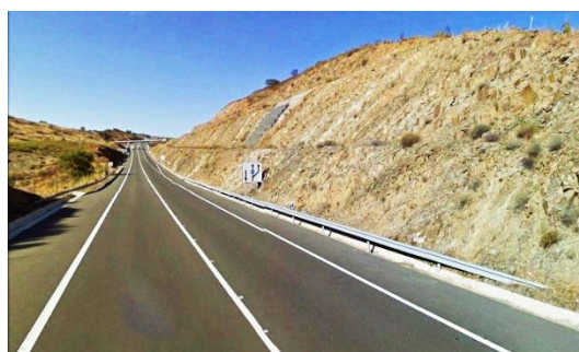
Fig. 29 - Talude de escavação no IC27 (Agosto de 2009) (fonte: Google Earth, consultado em Junho de 2014)
