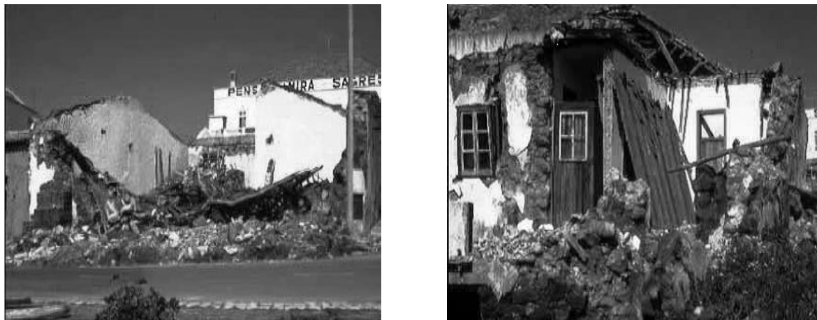
Figura 3.1 - Danos provocado pelo sismo de 1969 em Vila do Bispo, (PROTALGARVE, 2004).
