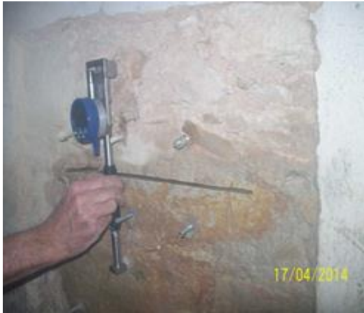
Figura 4.15 - Medição da descompressão.
