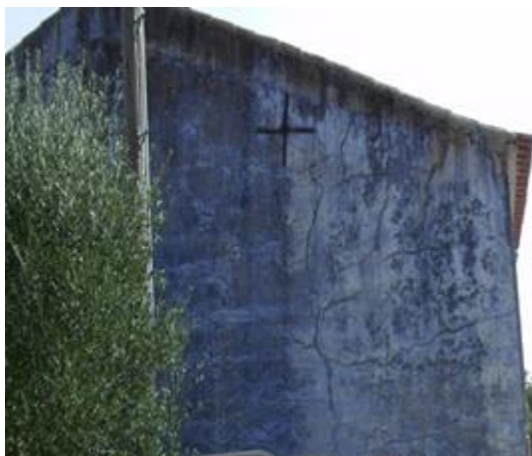
Figura 3.8 - Aplicação de tirante nas paredes frontais.
