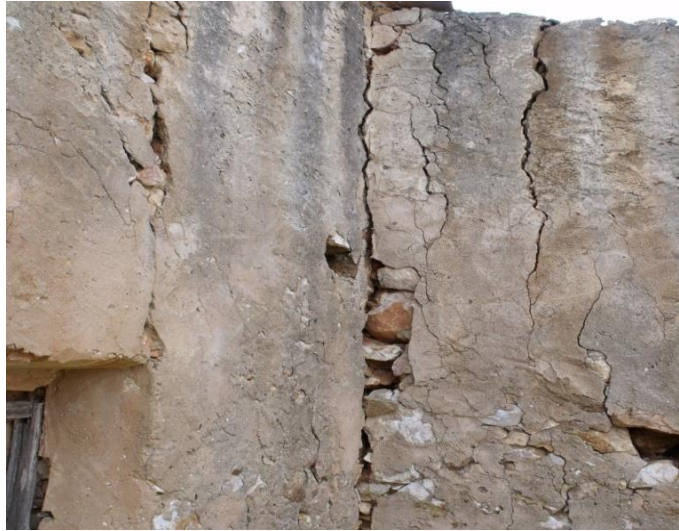
Figura 3.2 - Paredes resistentes ortogonais.
