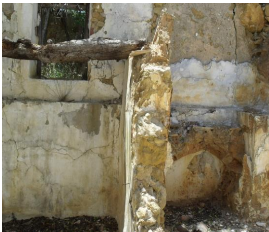
Figura 2.24 - Parede divisória de reduzida espessura.
