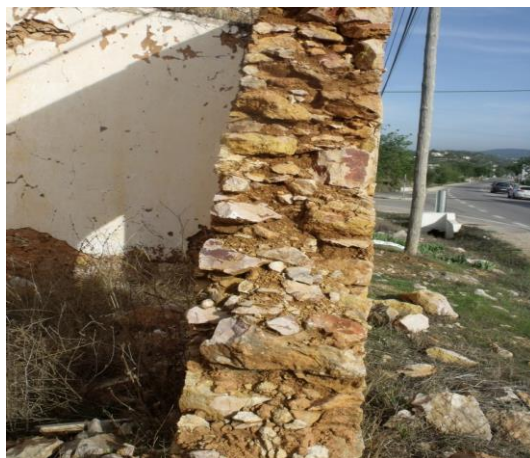
Figura 2.19 - Corto transversal da fachada.
