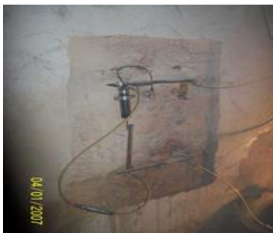
Figura 4.22 - Fixação dos transdutores.
