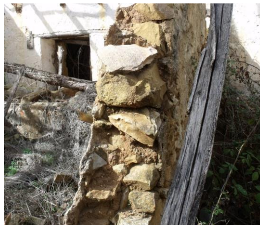
Figura 2.23 - Parede interior resistente.
