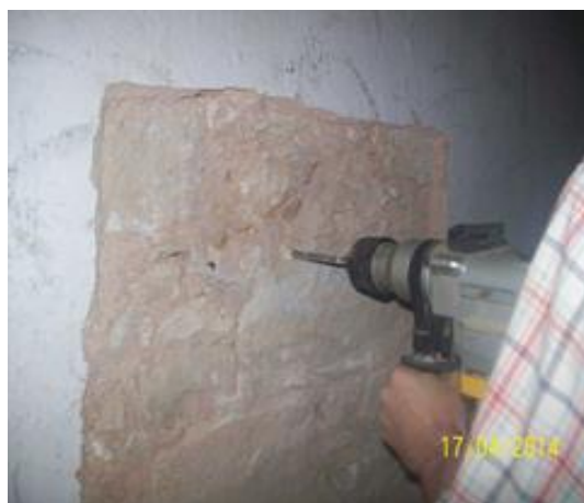
Figura 4.11 - Abertura dos furos.
