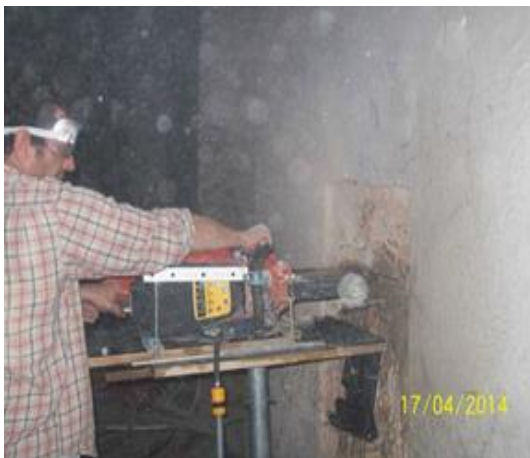
Figura 4.13 - Abertura do rasgo.
