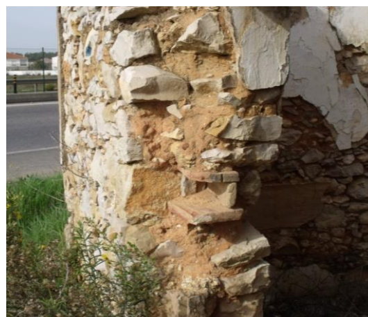
Figura 2.21 - Corto transversal da fachada.
