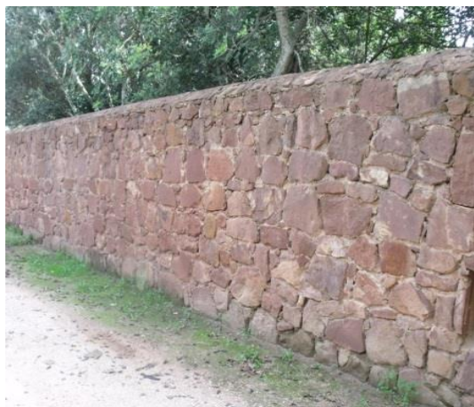
Figura 2.15 - Muro executado com grés, (Silves).
