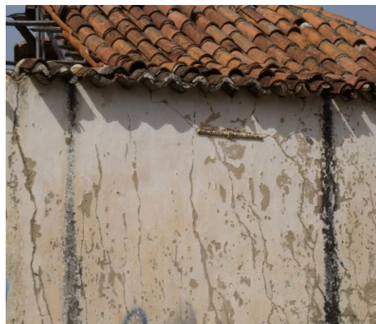
Figura 3.9 - Aplicação do tirante pelo exterior.
