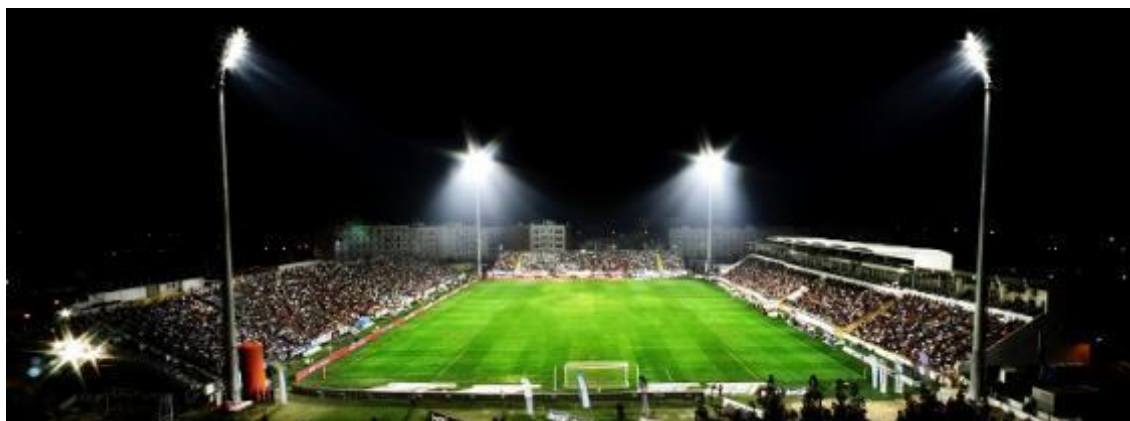
Figura III.3 Estádio José Arcanjo
