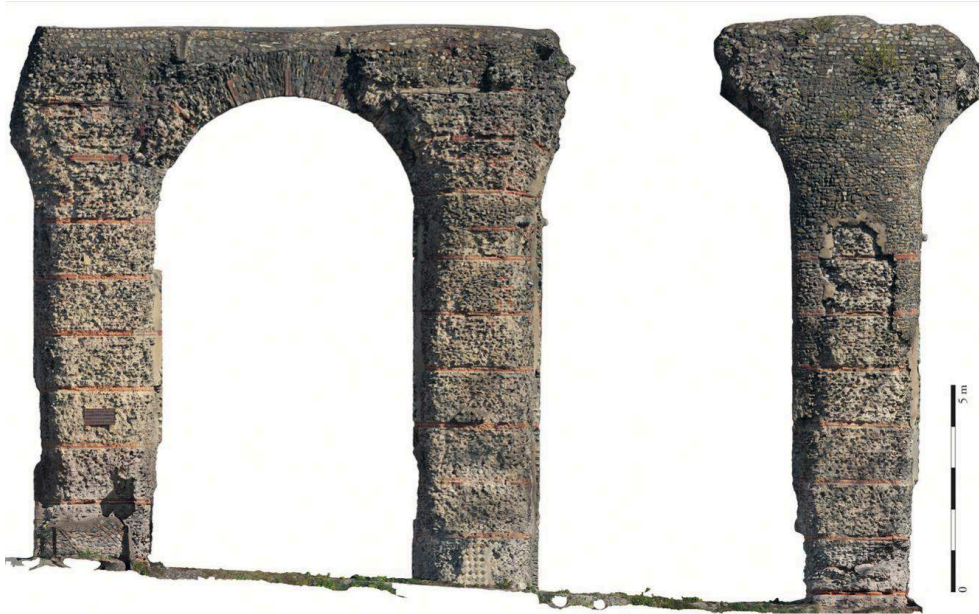
Fig. 3 – Orthoimage des faces sud des piles 8, 9 et 10
