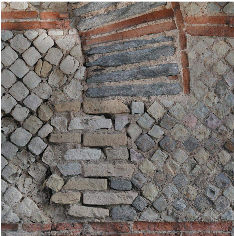
Fig. 4 – Orthoimage de la liaison entre le bouchage UC9.03 et le piédroit UC9.01 sur la face ouest de la pile 9 à hauteur de l'épaulée 9#6
