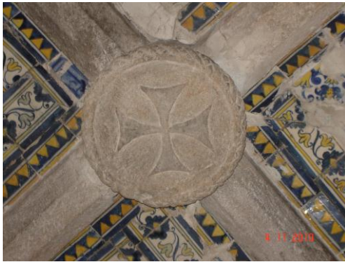
Figuras 29 e 30 - Bocetes formalmente semelhantes, no fecho das abobadas de nervuras chanfradas, em capelas colaterais nas duas igrejas
