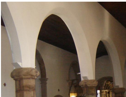
Figuras 25 e 26 - Arcos formeiros de volta perfeita e chanfrados, semelhantes nos dois templos
