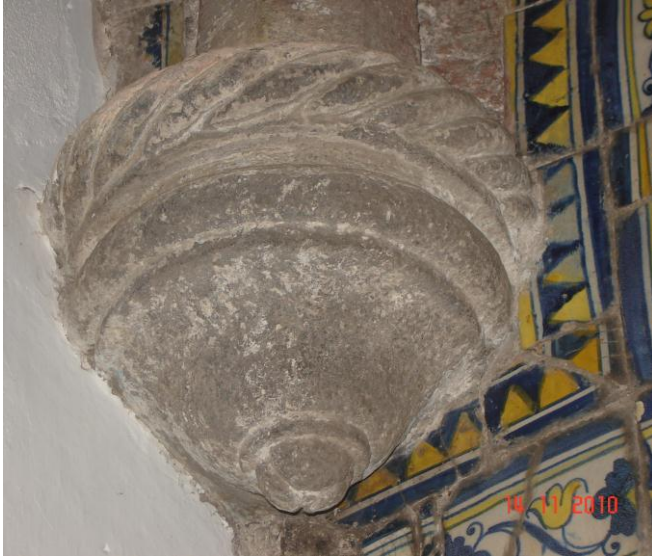
Figuras 96 e 97 - Mísulas da capela das Almas.
