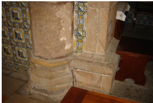
Figura 83 - Solução de encaixe forçado das cantarias do arco triunfal com a base da meia coluna adossada à cabeceira do lado do evangelho.
