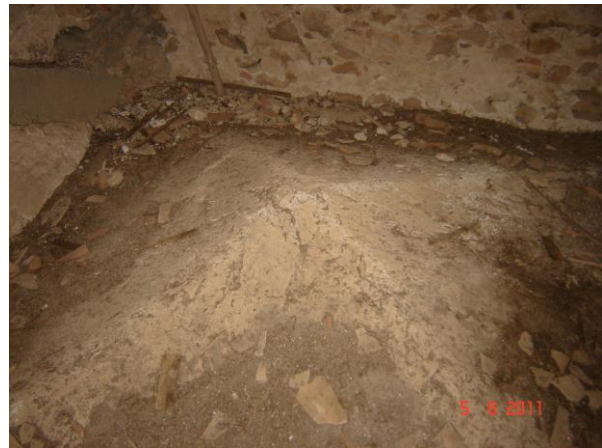
Figura 95 - Exterior da abóbada da capela das Almas.
