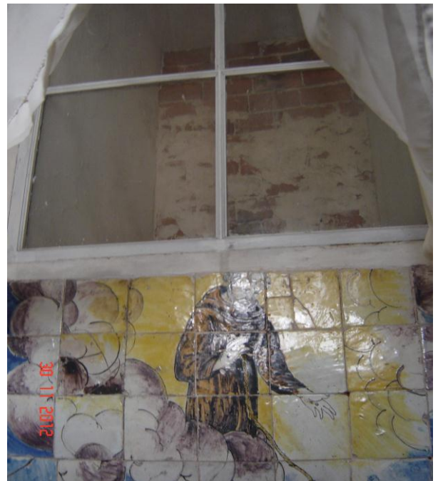
Figura 99 - Painel de azulejos com S. Francisco a resgatar as almas que se agarram ao seu cordão. Por cima, vê-se a janela, entaipada, que servia para iluminar a capela mor.
