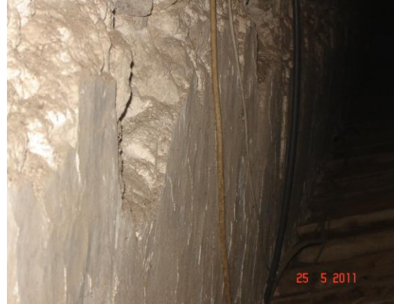
Figura 67 - Prolongamento do pano de parede na continuidade dos arcos formeiros acima do tecto de masseira, onde é visível a caiação e os sinais da colocação dos barrotes de uma anterior cobertura. Foto do autor, 2011
