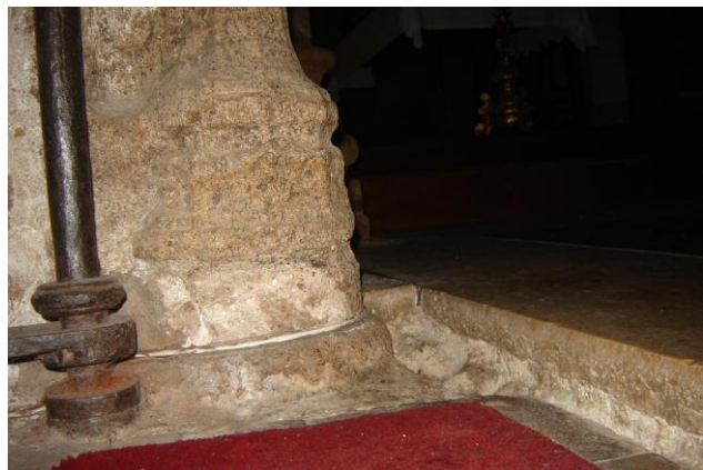
Figura 65 - Desnívelamento visível entre o pavimento da capela das Almas e o actual da igreja. Foto do autor, 2012
