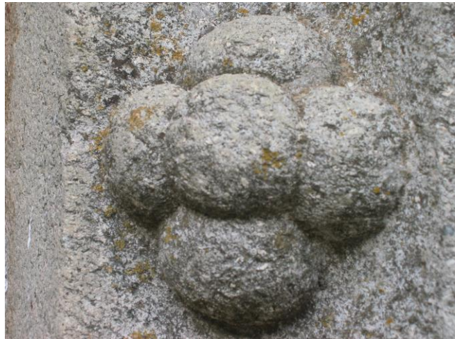
Figura 75 - Pormenor do decorativismo do portal sul. Foto do autor, 2012
