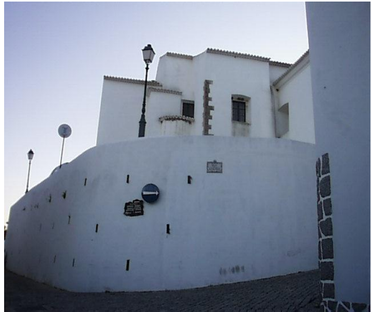
Figura 62 - Muro de suporte da rua/adro atrás da cabeceira, provavelmente levantado nos finais do séc. XIX para regulação do urbanismo de acesso e envolvência da igreja.
