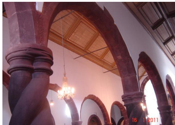
Figuras 25 e 26 - Arcos formeiros de volta perfeita e chanfrados, semelhantes nos dois templos
