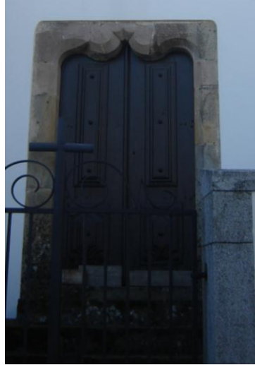
Figura 76 - Portal lateral norte da igreja matriz de Monchique.
