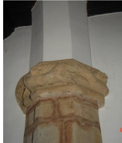
Figura 48 - Pormenor da meia coluna do lado do evangelho. Foto do autor, 2011
