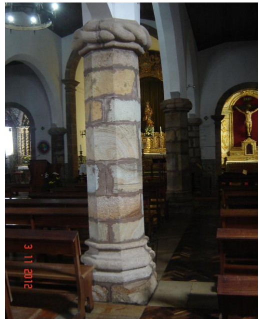
Figura 54 – Coluna completa em que se observa a base, o fuste e o capitel, na sua relação equilibrada
