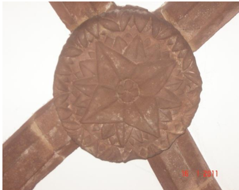
Figuras 29 e 30 - Bocetes formalmente semelhantes, no fecho das abobadas de nervuras chanfradas, em capelas colaterais nas duas igrejas
