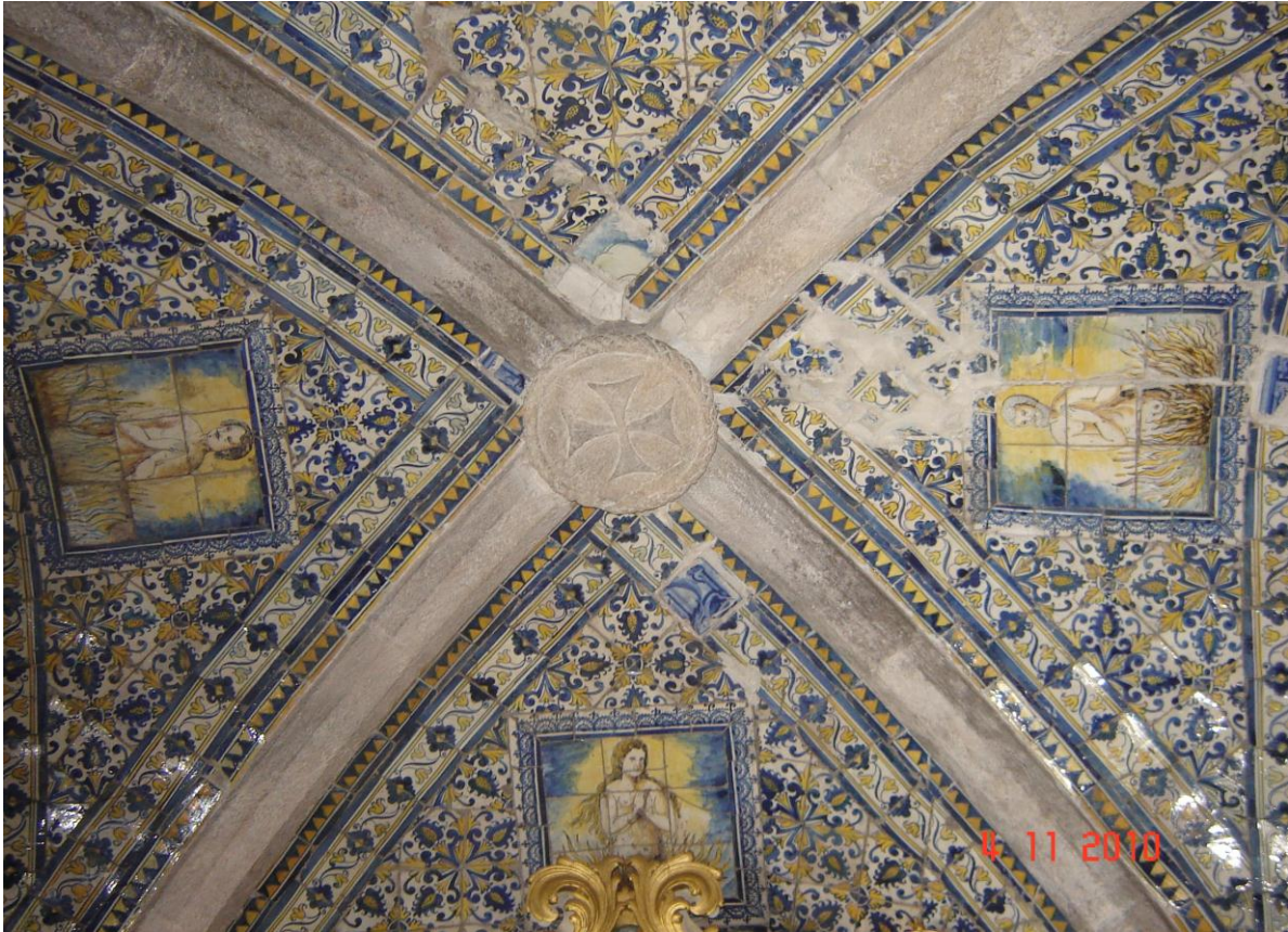
Figura 94 - Interior da abóbada da capela das Almas.
