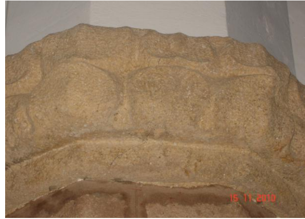
Figura 58 - Capitel de feição vegetalista da meia coluna número dois, adossada ao interior da parede frontal do lado da epístola.
