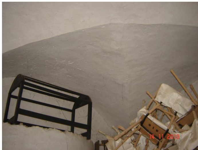
Figura 86 - A abóbada de arestas, da arrecadação por baixo da capela mor
