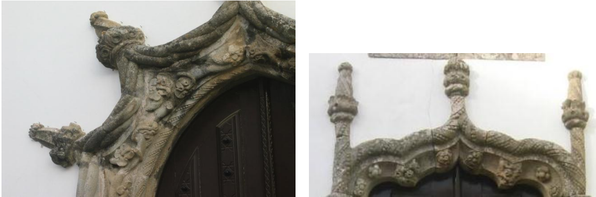
Figuras 72 e 73 - Pormenores nos cogulhos dos pórticos axial e meridional.
