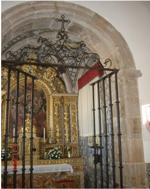
Figura 101 - Capela das Almas, onde se pode observar a articulação de vários suportes materiais como a pedra, a madeira, os azulejos, o ferro, a pintura...
