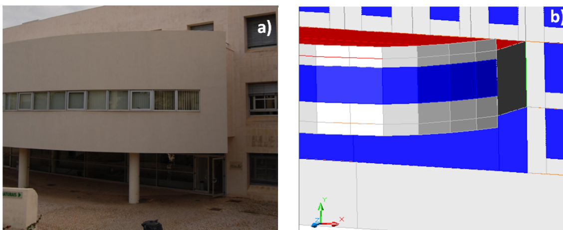
Figura 10: Comparação de uma fotografia (a) com o desenho (b), para se observar a extensão da fachada para cima e para baixo através de palas superiores e inferiores, voltada a Norte.
