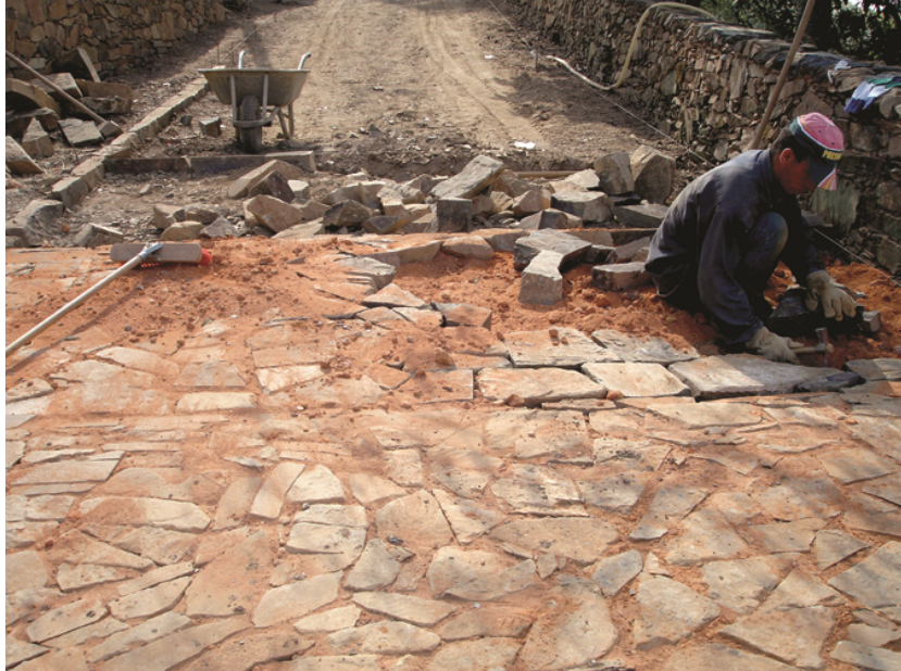
Figure 4. Execução de calçada irregular de xisto em projeto do Gtaa Sotavento (Ribeiro, 2008a: 192).
