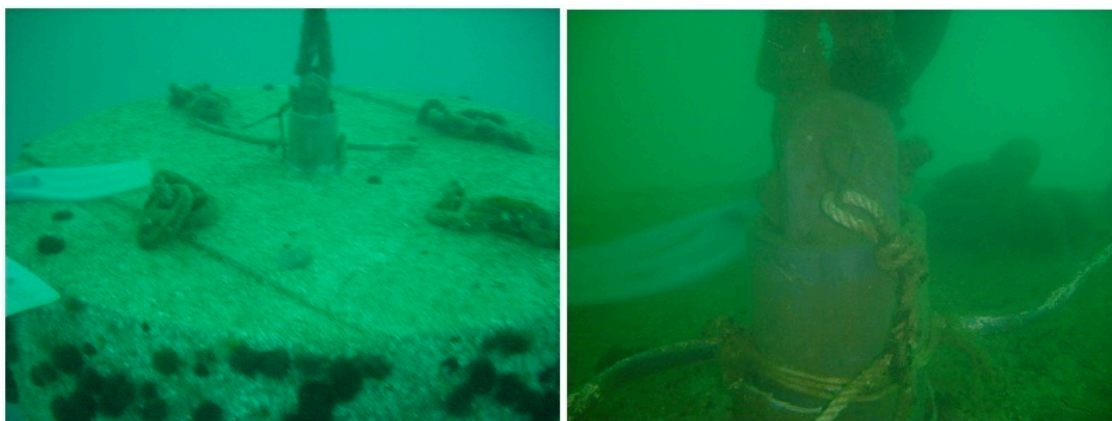
Figura 27: Lastro de 5 toneladas da jaula Sea Station®. À direita pormenor das peças envolvidas na conexão do lastro à jaula (Fonte: IPIMAR, Pousão-Ferreira).
