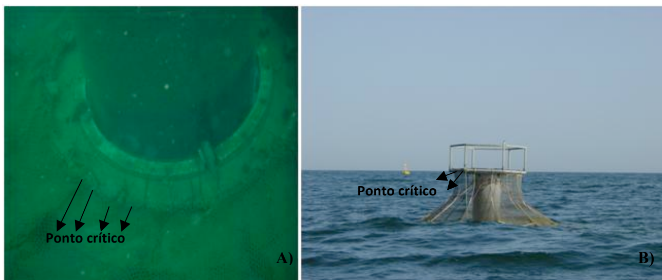
Figura 21: Pontos de conexão dos painéis de rede; A) parte inferior do tubo central) Parte superior do tubo central. (Fonte: IPIMAR, Pousão-Ferreira)
