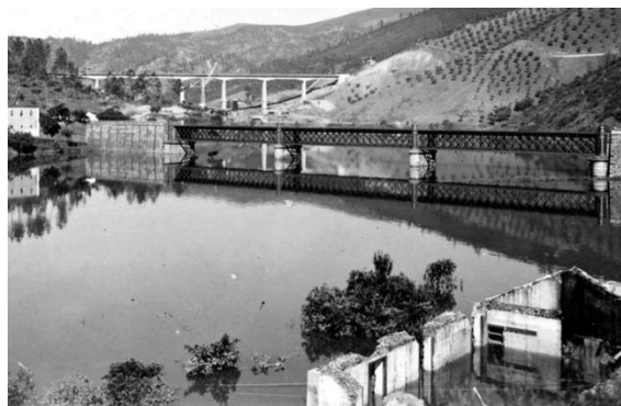
Figura 8 - Enchimento da albufeira da barragem do Castelo do Bode, com a ponte metálica e a de betão. A ponte metálica, em primeiro plano, ficará então submersa (fonte: (2)).
