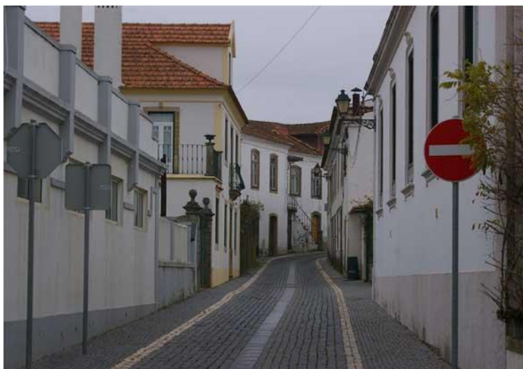
Figura 4 – Uma das ruas mais caracterizadoras de Cernache, a Rua Torta, já com coexistência de novas edificações. Fonte: autores, 2011
