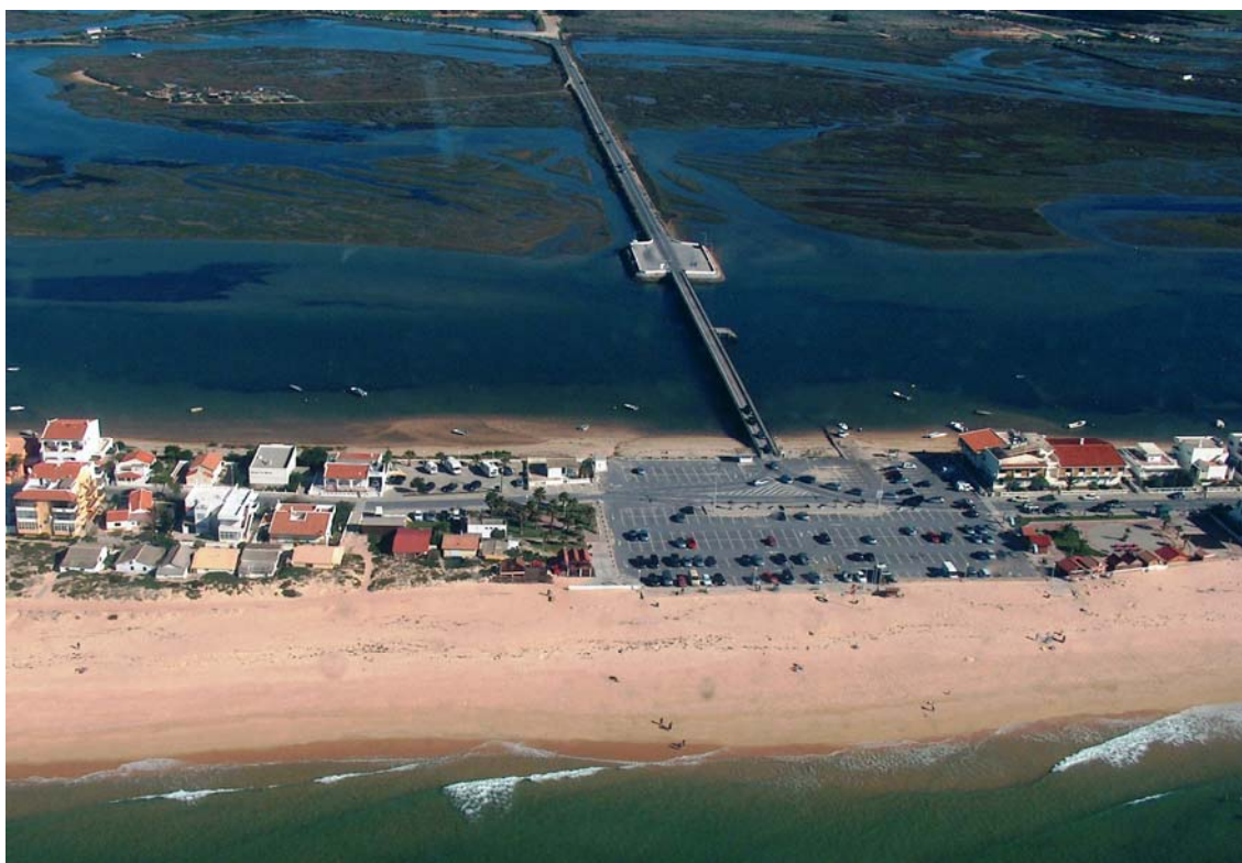
Figura 9 – Ponte de acesso rodoviário à Praia de Faro (fotografia obtida em Novembro de 2006, pelo autor).
