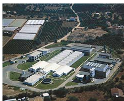
Figura 2 – ETA de Alcantarilha coberta (AdA, 2007c)
