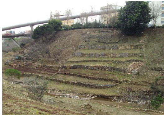
Figura 32 – Construção de socalcos nas zonas de declive acentuado. Fonte: Autor. 2010.
