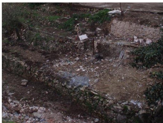
Figura 34 – Acumulação de lixo nas margens e leito da linha de água. Fonte: Autor. 2010.
