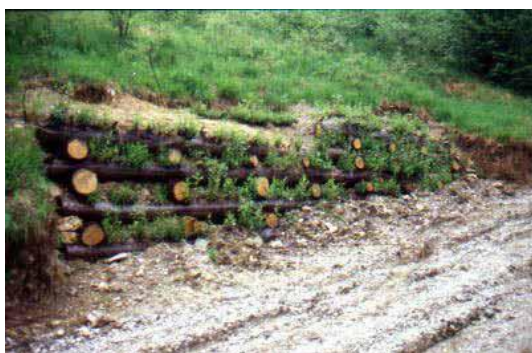
Figura 19 - Muro vivo duplo na altura da intervenção. Fonte: SAULI (2005).
