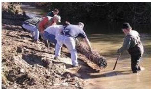
Figura 7 – Aplicação de um feixe vivo na margem de uma linha de água. Fonte: FERNANDES (2011).
