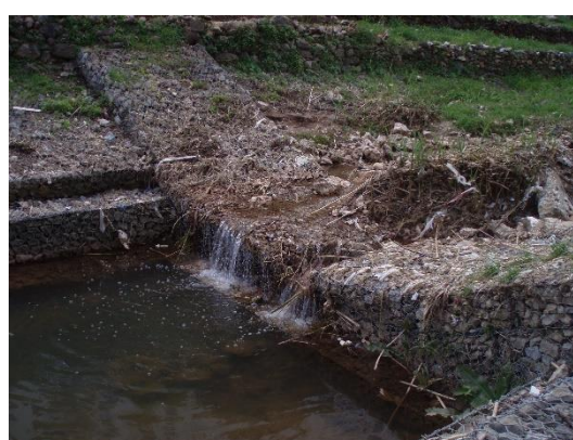
Figura 50 – Gabiões no leito da ribeira. Fonte: autor.2010.
