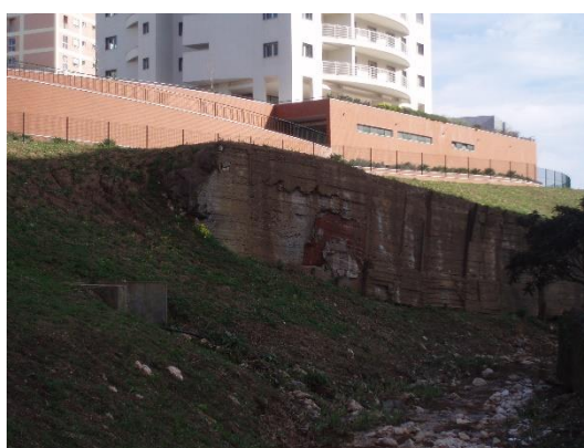
Figura 46 – Muro em betão no troço nº14. Fonte: autor.2010.
