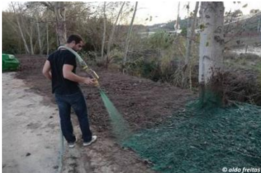
Figura 3 – Aplicação de Hidrossementeira.
