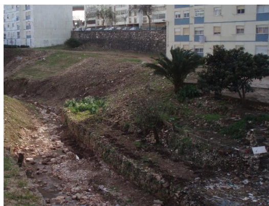
Figura 48 – Muro em alvenaria de pedra na margem da linha de água. Fonte: autor.2010.
