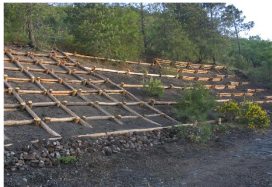
Figura 11 – Grade viva em construção. Autor: BIFULCO.
