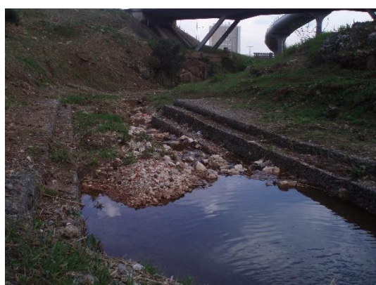
Figura 49 – Gabiões na margem da ribeira. Fonte: autor.2010.
