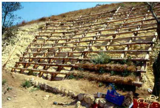
Figura 12 - Grade viva em construção. Colle S. Michele, Cagliari. Fonte: SAULI (2005).
