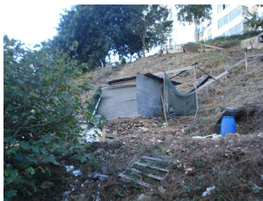
Figura 35 - Acumulação de lixo nas margens da linha de água. Fonte: Autor. 2010.
