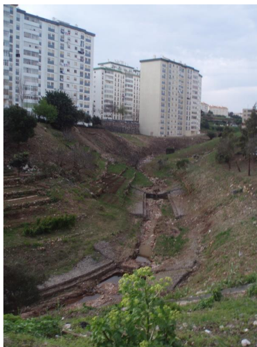
Figura 25 – Área de Intervenção. Fonte: Autor. 2010.
