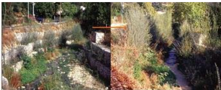
Figura 22 – Construção de gabiões vivos numa linha de água durante e após intervenção. Fonte: FERNANDES (2011).
