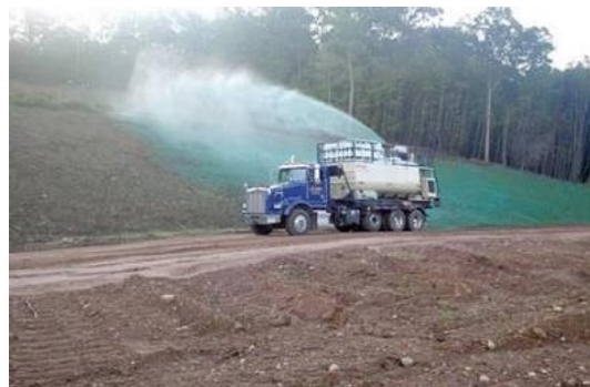
Figura 4 - Aplicação de Hidrossementeira.
