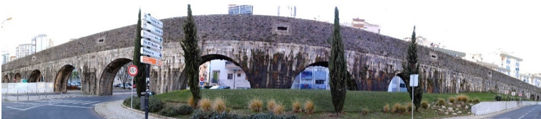
Figura 19 Troço do AAL na Reboleira, possuindo um conjunto de 20 arcos, e interligando a Travessa da Quinta do Bosque, à estação de comboios da Reboleira, paralelo à Rua das Indústrias.
