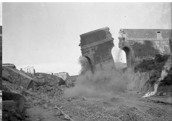
Figura 40 O aqueduto das Águas Livres, na zona das terras de Santana, momento da sua demolição para a abertura da avenida Infante Santo 1949. Fonte: Arquivo Municipal de Lisboa
