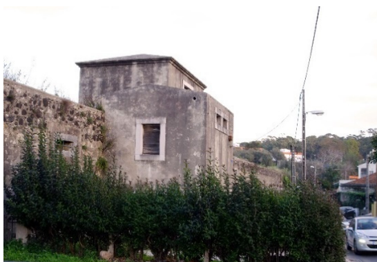
Figura 23 Clarabóia do Calhariz de Benfica, e acesso ao interior do Aqueduto, 2015, fotografia do candidato
