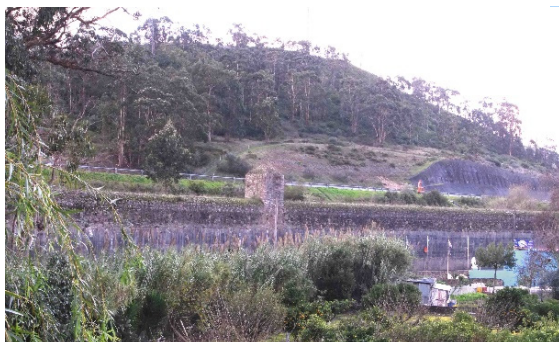
Figura 14 Paralelismo na construção do AAL com a ribeira de Carenque Fotografia tirada pelo candidato.
