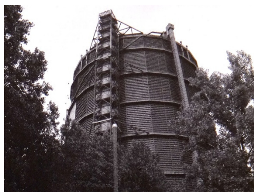
Figura 85 IBA Emscher Park, Duisborg Nord, Alemanha; 1999. Reconvers o do antigo gas metro de Oberhausen numa sala de exposi es e miradouro rio. Fonte: Enric Batlle, El Jardin de la Metr poli, p g. 97
