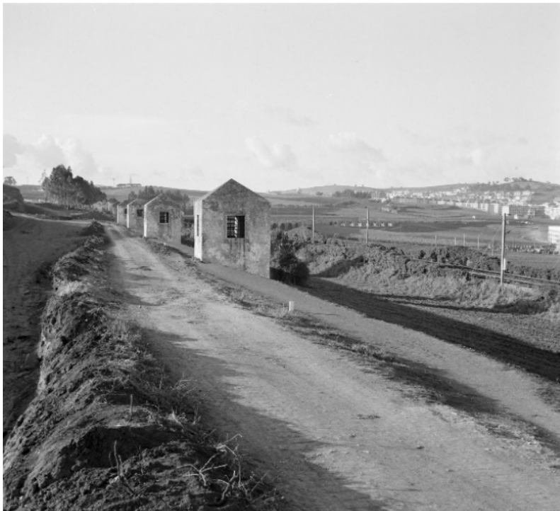
Figura 37 Aqueduto junto à ferrovia da Damaia-Reboleira. 1961. Fonte: Arquivo Municipal de Lisboa
