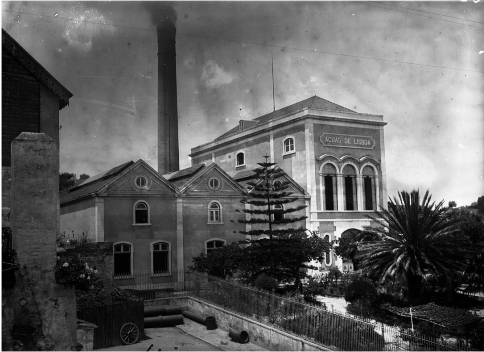
Figura 36 Edifício da Estação elevatória dos Barbadinhos, 1906, Fotografia de: Alberto Carlos Lima Fonte: Arquivo Municipal de Lisboa
