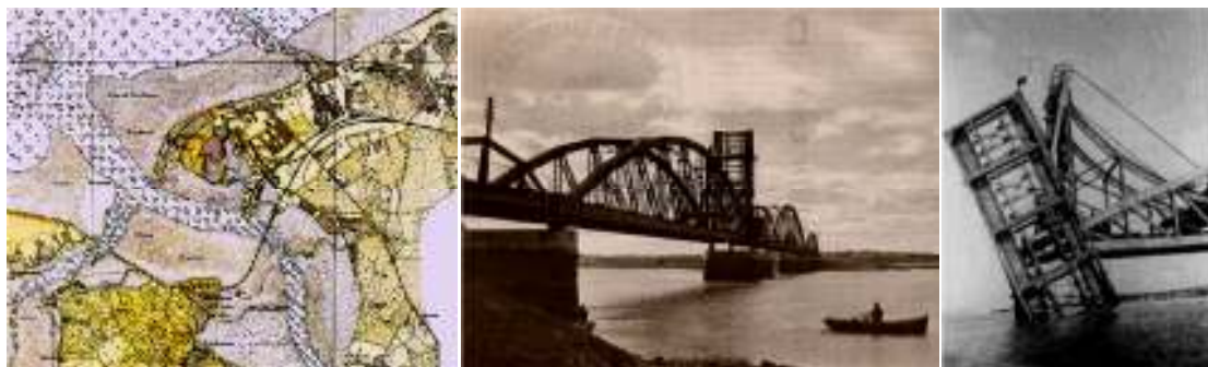
Imagem 37: Antiga ponte ferroviária Seixal / Barreiro
