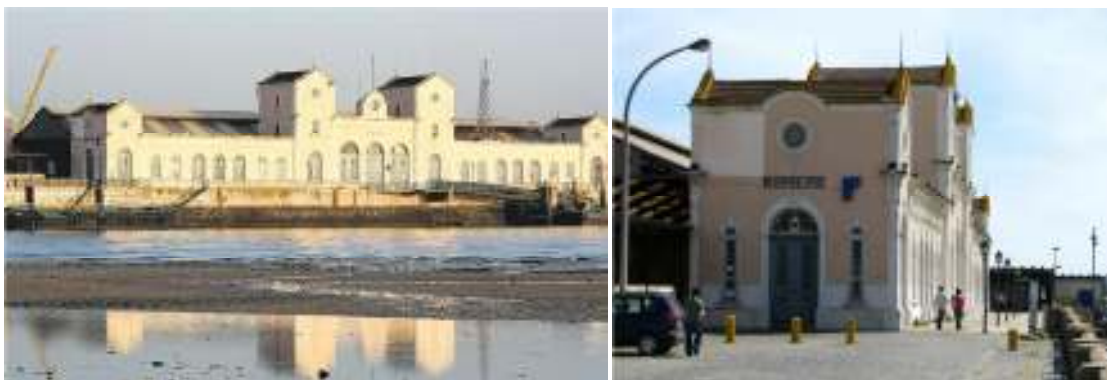
Imagem 35: Estação Ferroviária do Barreiro Fonte: http://4.bp.blogspot.com/6lFUmpDkRU/T_fcGQPboqI/AAAAAAAXms/cgvY4nwcSck/s1600/77509.jpg
