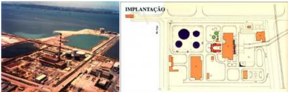
Imagem 38: Vista aérea da Estação termoelétrica e plano de implantação
