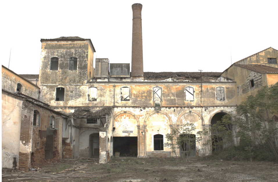
Fig. 30– Vista do interior do recinto.
