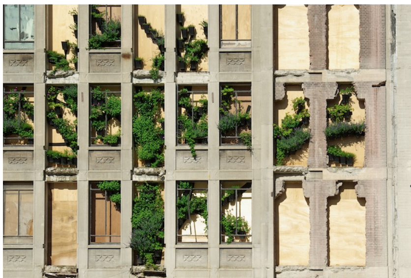
Fig. 1– Fachada reutilizada do edifício de Roterdão durante o período de obras do edifício.
