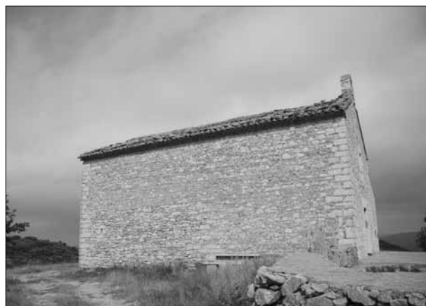
Fig. 4 Exterior de l'ermita: murs de maçoneria ordinària.
