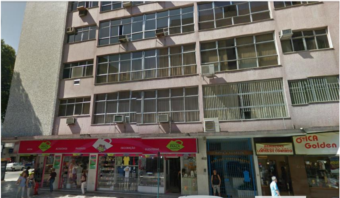
Figura 56: Edifício Rua Santo Afonso, 413 e sua envolvente urbana. Fonte: Google, 2013.
