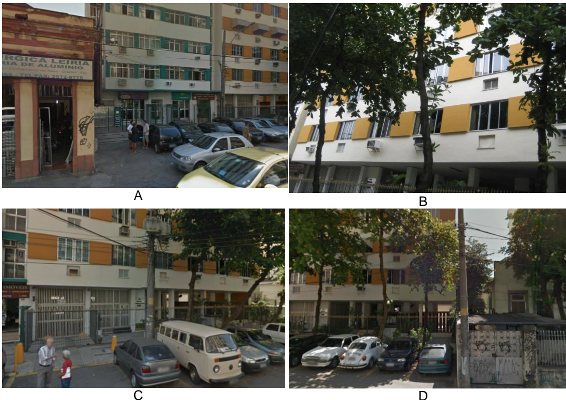
Figura 50: (A – D): Edifício na Rua Barão de Mesquita, 510 e sua envolvente urbana, 2012.
