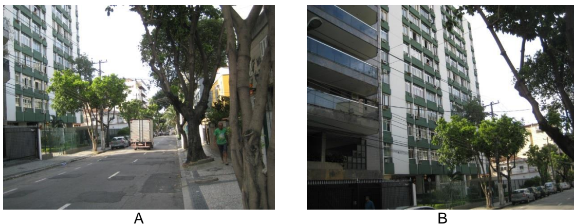
Figura 78 (A - B): Edifício Rua Marques de Valença, 25 e sua envolvente urbana, 2012.
