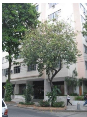
Figura 62: Edifício Rua Desembargador Isidro, 103 e sua envolvente urbana, 2012.
