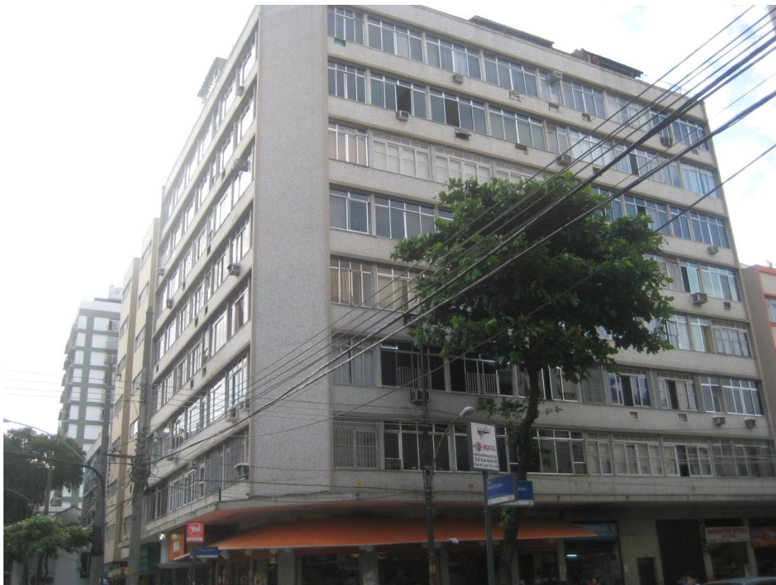
Figura 73: Edifício Rua Professor Gabizo, 81 e sua envolvente urbana, 2012.
