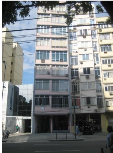
Figura 80: Edifício Rua São Francisco Xavier, 22 e sua envolvente urbana, 2012.
