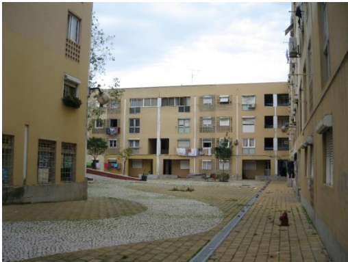
Figura 10: Operação Quinta das Fonseca/Calçada - Raul Hestnes Ferreira. Fonte: RAMOS, 2012
