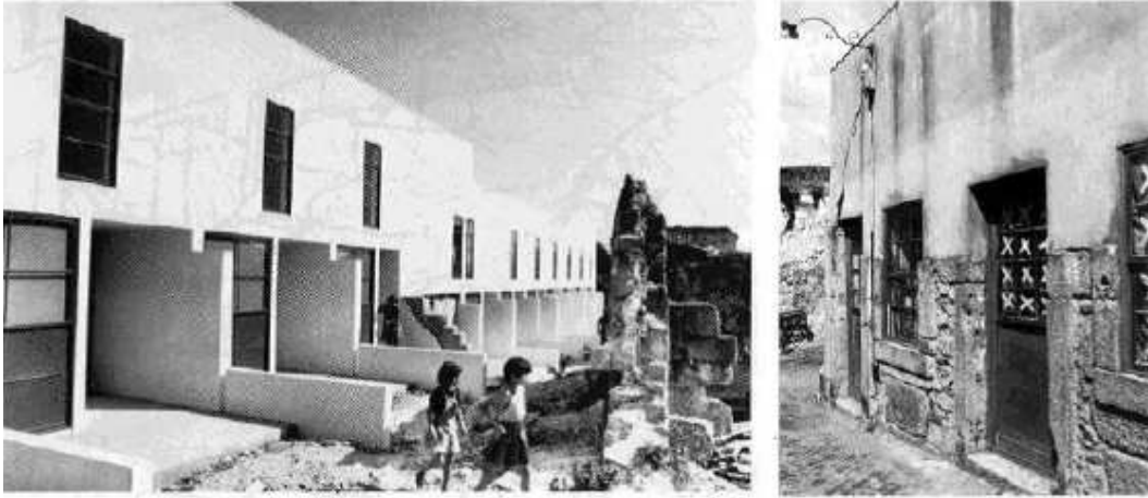
Figura 114. Álvaro Siza Vieira, vista sobre as habitações do Bairro de São Víctor, Porto
