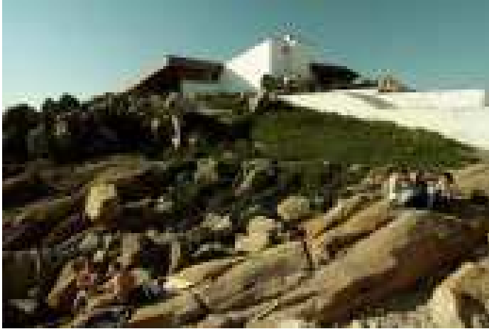
Figura 121. Álvaro Siza Vieira, Casa de Chá da Boa Nova, Leça da Palmeira, 1958/1963
