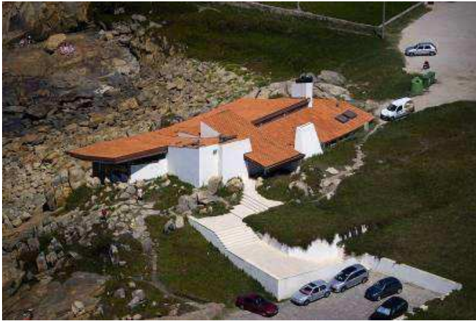
Figura 111. Álvaro Siza Vieira, Vista sobre o Restaurante da Boa Nova (1958-63)
