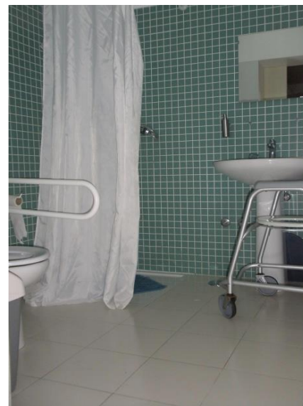
Figura 69 - Lar - Instalação sanitária
