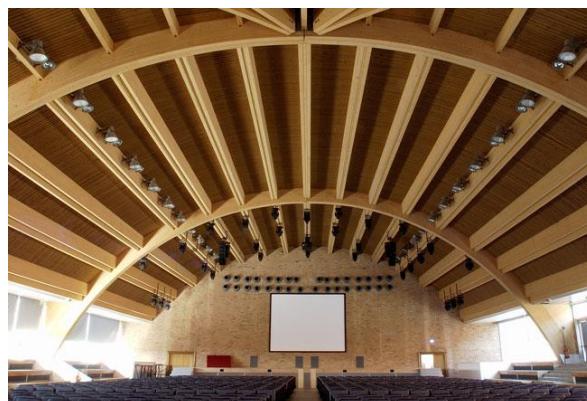
Fig. 22 - Auditório com estrutura arqueada
