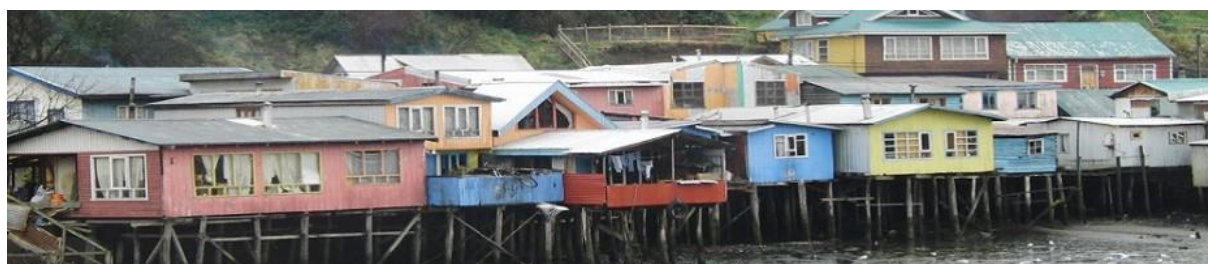
Fig. 24 - Conjunto atual de construção em palafitas
