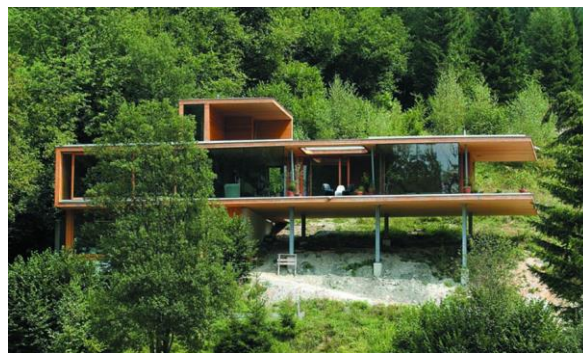
Fig. 20 - Habitação unifamiliar construída com o sistema Massiv
