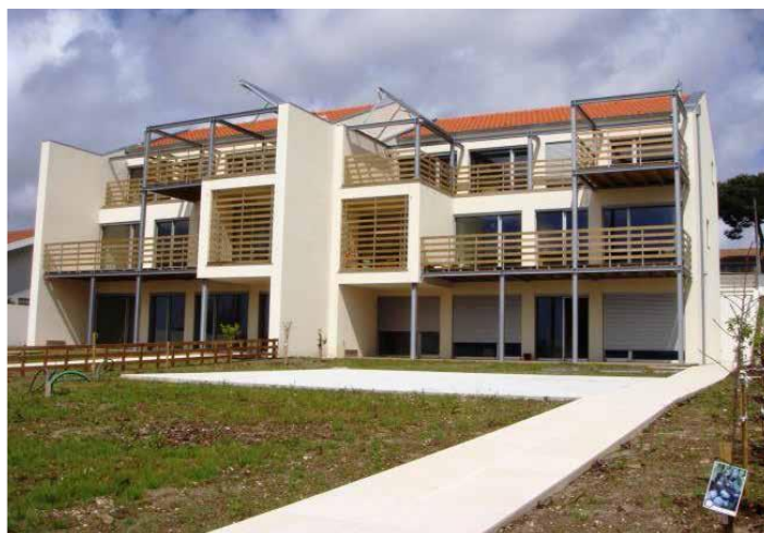
Figura 25 – Vista da parte exterior do edifício (Fonte: PHI, 2014)
