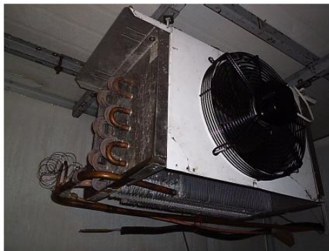
Ilustración 20 - Evaporador de serpentín aleteado y convección forzada para baja
