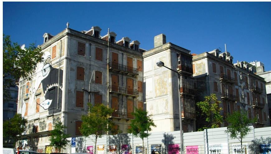
Fig. 23 – Fotografia das traseiras dos edifícios e da relação com o vazio urbano
