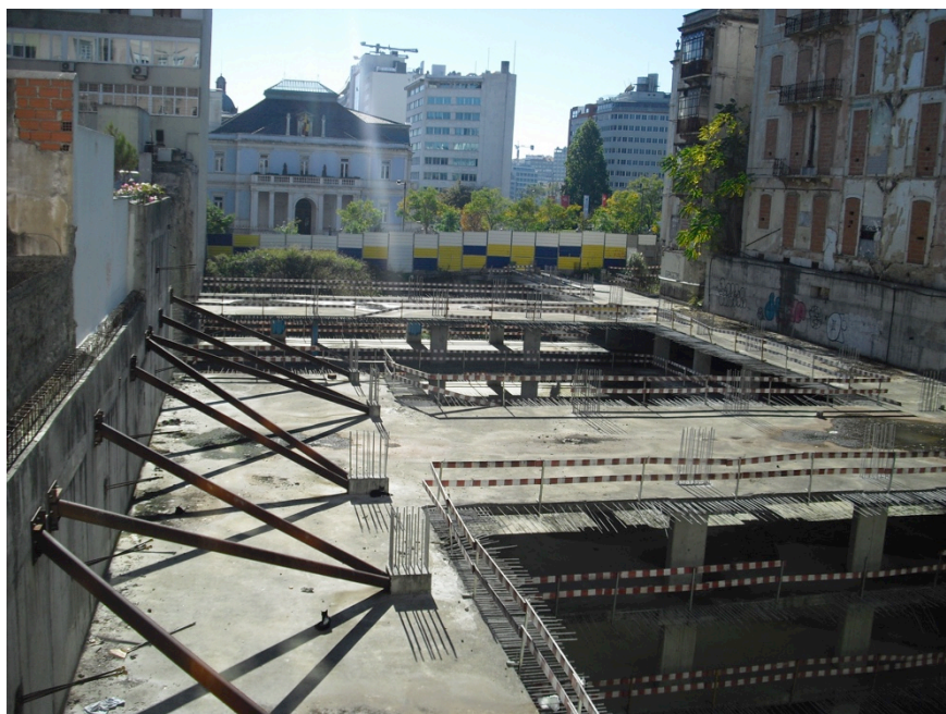
Fig. 42 – Estrutura existente que condicionou parte do projecto no vazio
