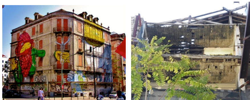
Fig. 29 e Fig. 30 – Situação actual do edifício A
