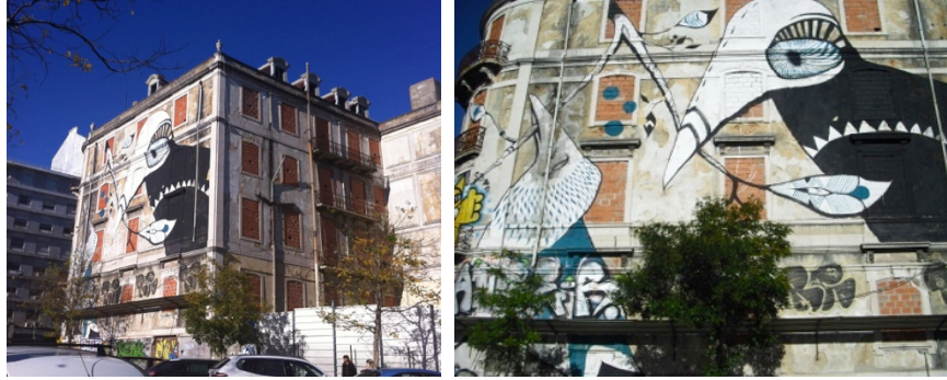
Fig. 36 e 37 – Situação actual do edifício C
