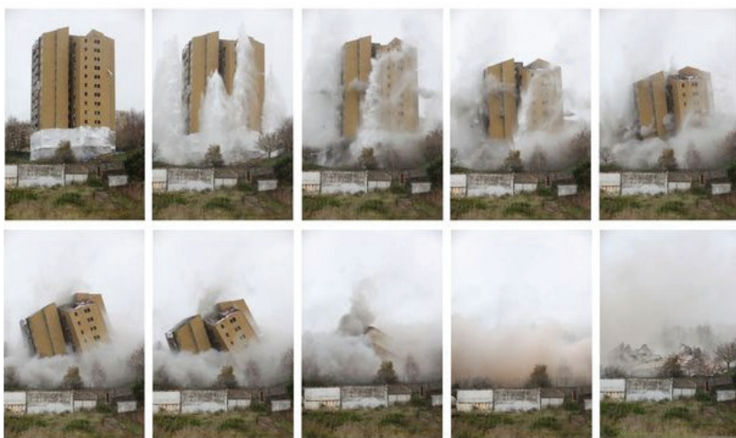
24. Sequência da demolição da Torre 5 do Bairro do Aleixo, Porto, 16 de Dezembro de 2011
