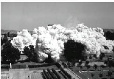
10. Demolição dos grands ensembles , França entre os anos 1950 e 1970
