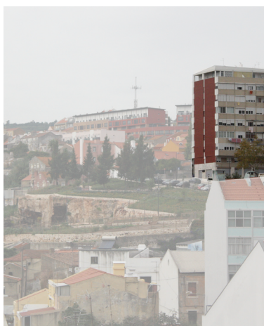
27. Frente ponte da banda norte
