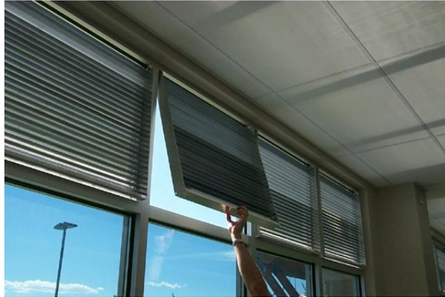
fig 29 - Persianas de condução do tipo pala ajustável, aplicadas acima da linha de visão.
