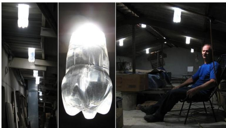
fig 32 - Projecto de iluminação natural sustentável, por transporte de luz através de garrafas de água.
