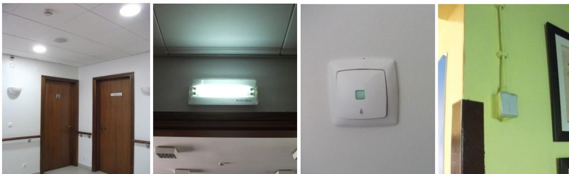
fig 62 – Iluminação LED e de emergência; interruptor bem sinalizado e um por renovar (30.06.14).
