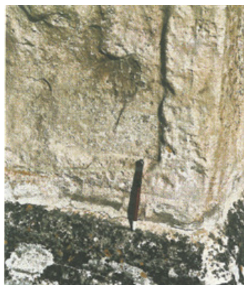
Figura 206 – Pulverização (arenização ou enfarinhamento) do calcário, Universidade de Coimbra [Barros, Luís Aires (2001)]
