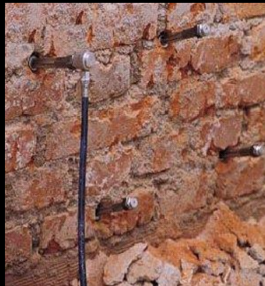
Injecção de caldas ligantes
