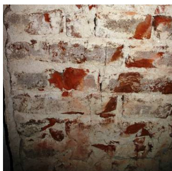
Figura 381 – Pormenor de aparelhamento de um pilar de alvenaria cerâmica interior [LEB (2008)]
