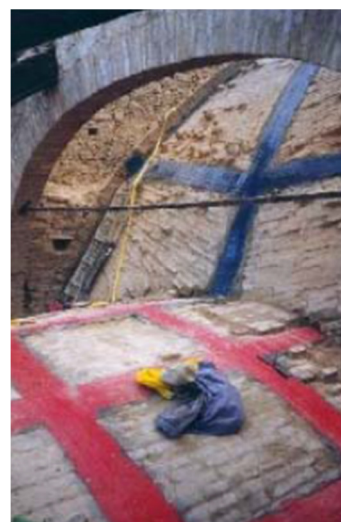
Figura 302 - Preparação de extradorso de abóbada para colagem de laminados de carbono
