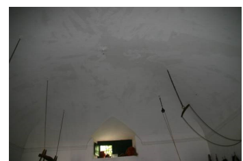
Figura 379 – Abóbadas de barrete de clérigo [LEB (2008)]
