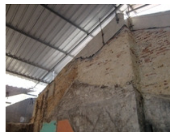
Figura 78 – Protecção de estrutura intervencionada, Travessa da Peixeira, Lisboa [Foto LEB]
