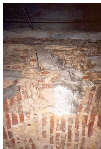
Figura 285 – Injecção de fissura em arco de tijolo maciço [Flores, Inês; Brito, Jorge (2004b)]
