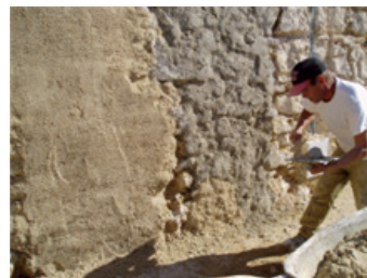
Figura 255 - Aplicação em obra de argamassa de cal [Aguiar, José; Pinho, Ana; Paiva, J. Vasconcelos (2006)]
