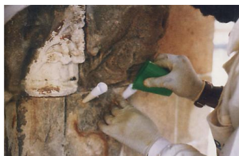
Figura 279 - Injeção de consolidantes inorgânicos por gravidade
