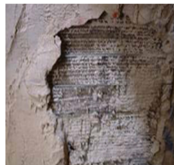
Figura 286 - Aplicação de reboco com armadura metálica [Branco, Fernando; Brito, Jorge (2010)]
