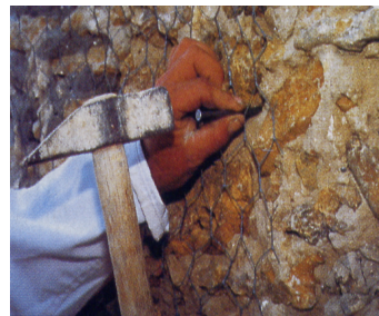
Figura 266 – Colocação da “armadura em ponte” sobre a fissura
