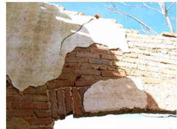
Figura 131 - Argamassas de revestimento em parede de alvenaria, Casa das Almeidas [Foto LEB]
