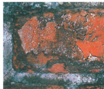
Figura 202 – Lascagem em alvenaria cerâmica
