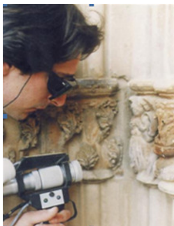
Figura 246 – Limpeza a Laser [Flores, Inês; Brito, Jorge (2004a)]
