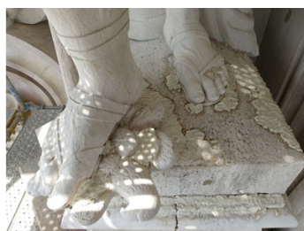
Figura 343 - Limpeza com compressas [Fotografia José Aguiar]
