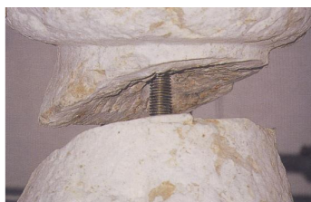
Figura 275 – Fixação de elementos destacados com varões roscados [Flores, Inês; Brito, Jorge (2004a)]
