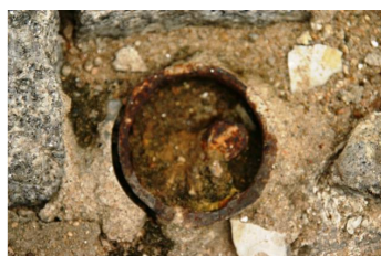
Figura 384 – Pormenor de cabeça de uma microestaca de reforço existente na base da fachada Oeste [LEB (2008)]
