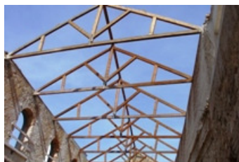
Figura 80 – Estruturas treliçadas, Museu de Portimão [Foto LEB]
