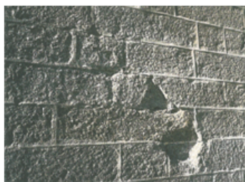
Figura 204 – Separação em placas com lacunas, Escorial de Madrid [Barros, Luís Aires (2001)]
