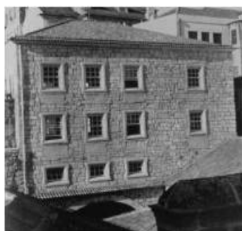
Figura 41 - Casa do Infante no Porto, depois da intervenção em 1961 [Ramalho, M. de Magalhães (2008)]
