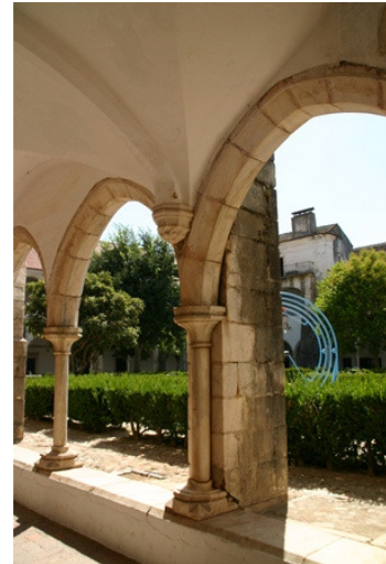
Figura 349 - Arcadas do registo inferior com arcos e fustes de mármore [LEB (2010a)]
