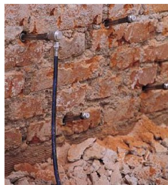
Figura 284 – Injecções de caldas ligantes em alvenaria ordinária de tijolos [Flores, Inês; Brito, Jorge (2004b)]
