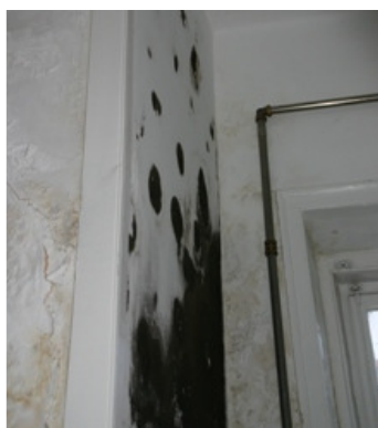
Figura 216 – Depósito biológico acentuado em paredes interiores, Condomínio Pátio Lencastre, Lisboa [Foto LEB]
