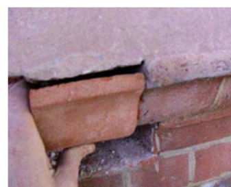
Figura 277 - Reposicionamento de tijolo cerâmico [Branco, Fernando; Brito, Jorge (2010)]
