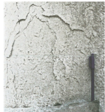
Figura 208 – Escamação múltipla, Mosteiro da Batalha [Barros, Luís Aires (2001)]
