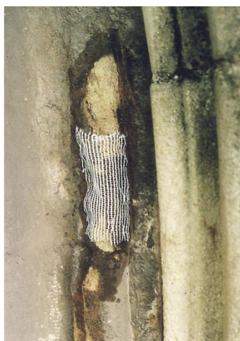
Figura 248 – Limpeza com compressas biológicas [Flores, Inês; Brito, Jorge (2004a)]
