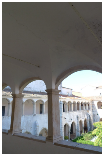
Figura 300 - Aplicação de tirantes passivos não aderentes para estabilização de abóbada, Convento das Maltezas, Estremoz [Foto do autor]
