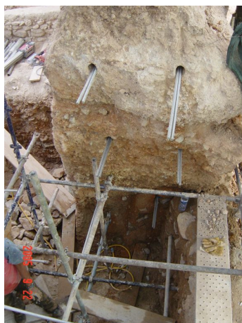
Figura 293 - Aplicação de pregagens aderentes para reforço estrutural, Castelo de Paderne [LEB (2005)]
