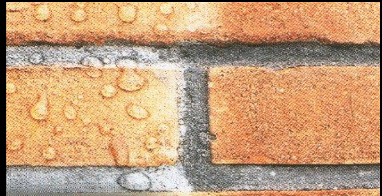
Efeito da aplicação de um líquido hidrófugo
