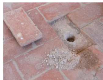
Figura 65 – Caroteamento para observação da composição do material de carregamento das abóbadas, Convento das Maltezas, Estremoz
