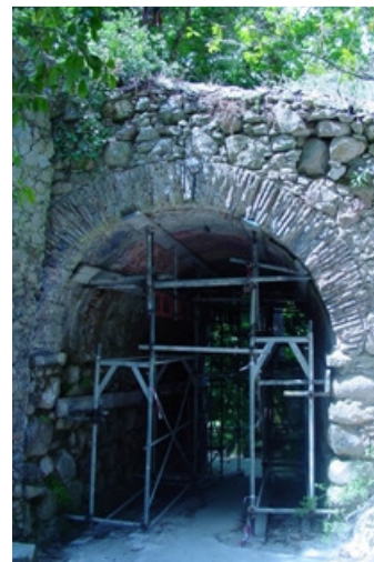
Figura 77 – Escoramento do cesso principal, Arco de Monserate, Sintra [Foto LEB]
