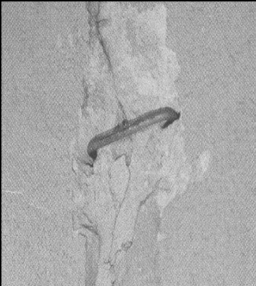
Grampo metálico em cozimento de fenda
