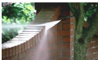
Figura 242 - Limpeza com Jactos de água com pressão controlada [Branco, Fernando; Brito, Jorge (2010)]
