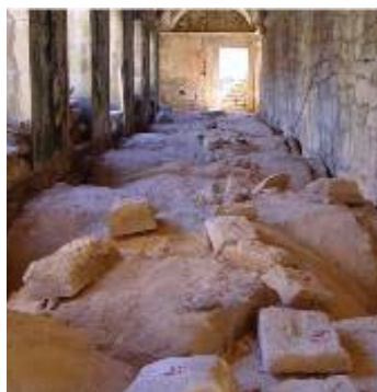
Figura 232 - Remoção do carregamento de abóbadas para posterior reforço, Mosteiro das Salzedas [Lourenço, Paulo B. et al (2008)]
