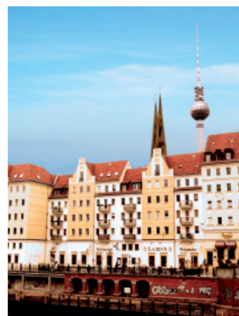
Figura 28 e 29 - Reconstrução mimética de fachadas de edifícios antigos destruídos com elementos prefabricados de betão, Varsóvia e Berlim
