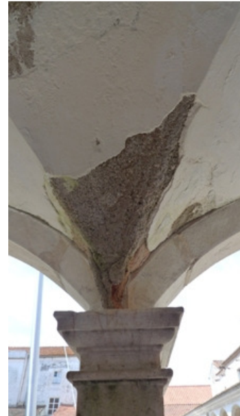
Figura 217 – Exfoliação e destacamento de várias camadas de revestimento sucessivas, Claustro do Convento das Maltezas em Estremoz [Foto LEB]
