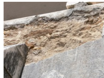
Figura 218 – Destacamento de revestimento, Claustro do Convento das Maltezas em Estremoz [Foto do autor]
