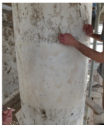
Figura 344 - Correção áreas erodidas, zona de teste [Fotografia José Aguiar]
