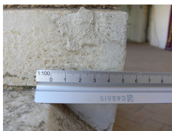
Figura 352 - Verificação geométrica de elementos de suporte [LEB (2010a)]
