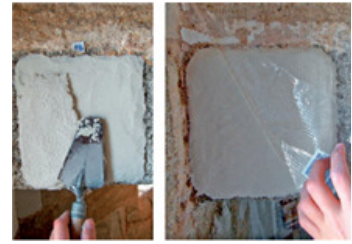
Figura 249 - Utilização de pastas para dessalinização de paramento de parede de pedra [Aguiar, José; Pinho, Ana; Paiva, J. Vasconcelos (2006)]
