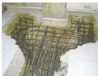
Figura 310 - Alargamento de fundações sem suspensão de carga
