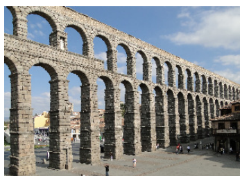
Figura 413 - Aqüeduto de Segóvia [http://en.wikipedia.org/]
