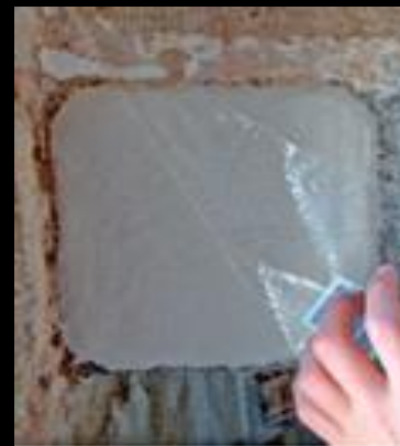
Tratamento de eflorescências pastas absorventes
