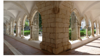
Figura 348 - Espaços do claustro suportados por abóbadas de ogivas e arestas [LEB (2010a)]
