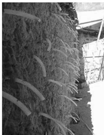
Figura 283 – Tubos de injeção e purga aplicados [Flores, Inês; Brito, Jorge (2004b)]
