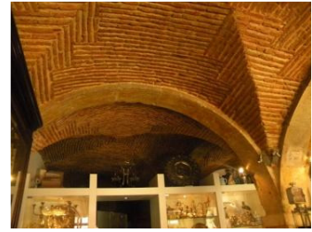
Figura 118 - Abóbadas de aresta. Piso térreo pombalino [ http://en.wikipedia.org/ ]
