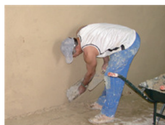
Figura 256 - Regularização e aperto de argamassa de cal e acabamento a talocha [Aguiar, José; Pinho, Ana; Paiva, J. Vasconcelos (2006)]
