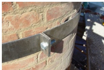
Figura 79 – Cinta de Reforço, Museu de Portimão [Foto LEB]
