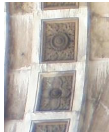
Figura 333 - Depósitos de escorrência brancos (arcos interiores) [Atelier 15 (2011)]
