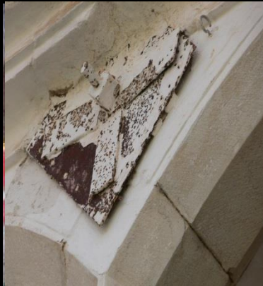
Reforço com tirantes metálicos
