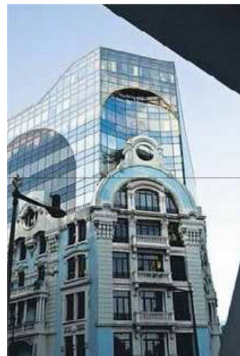
Figura 58 – Operação de fachadismo Rua Castilho, Lisboa [Ramalho, M. de Magalhães (2008)]
