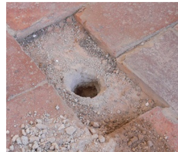
Figura 356 - Execução de carotes para observação do material de carregamento das abóbadas [LEB (2010a)]
