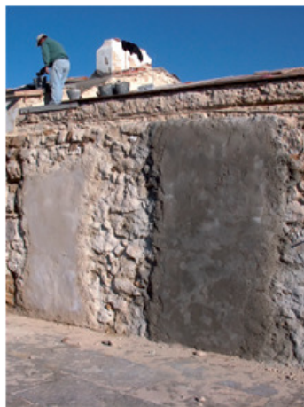
Figura 257 - Painéis experimentais para definição de revestimento a utilizar em intervenção de reabilitação
