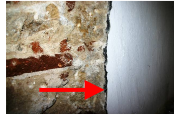
Figura 385 – Membrana impermeabilizante em parede interior [LEB (2008)]
