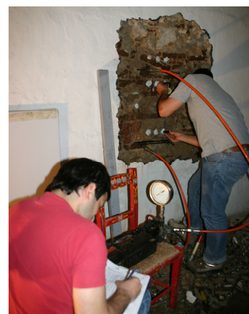
Figura 388 e Figura 389 – Corte na parede de alvenaria para instalação de macacos planos; Realização do ensaio [LEB (2008)]
