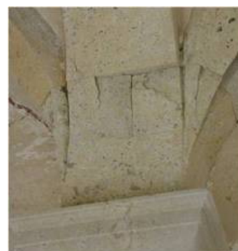
Figura 193 - Esmagamentos localizados nas nascenças das abóbadas, Mosteiro das Salzedas [Lourenço, Paulo B. et al (2008)]
