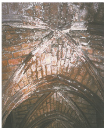
Figura 198 – Eflorescências generalizadas no fecho das abóbodas, Claustro da Sé de Lisboa [Barros, Luís Aires (2001)]
