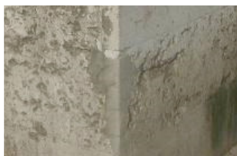
Figura 334 - Remendos e Reconstruções de cimento [Atelier 15 (2011)]
