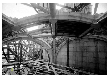
Figura 135 - Ligação de cimbres com elementos de madeira com pregagens [Fitchen, John (1961)]
