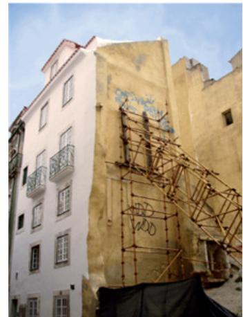
Figura 179 – Escoramento na sequência de demolição de edifício contíguo [Aguiar, José; Pinho, Ana; Paiva, J. Vasconcelos (2006)]
