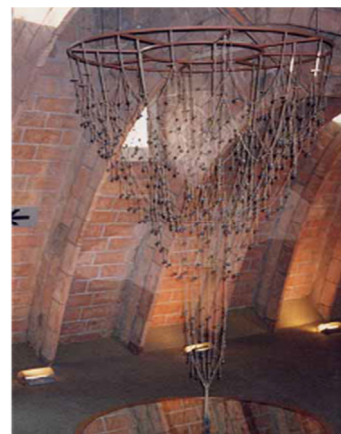
Figura 154 – Modelo de Gaudí para o dimensionamento de cúpulas através da analogia entre arcos e correntes suspensas [Gago, António (2004)]
