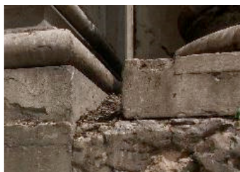
Figura 335 - Dejectos e outros depósitos de aves [Atelier 15 (2011)]
