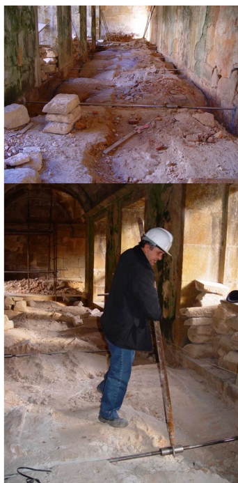
Figura 296 - Reforço estrutural de abóbada com tirantes, Mosteiro das Salzedas [Lourenço, Paulo B. et al (2008)]
