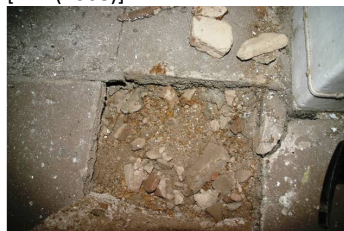
Figura 382 – Material de enchimento das abóbadas - carrego [LEB (2008)]
