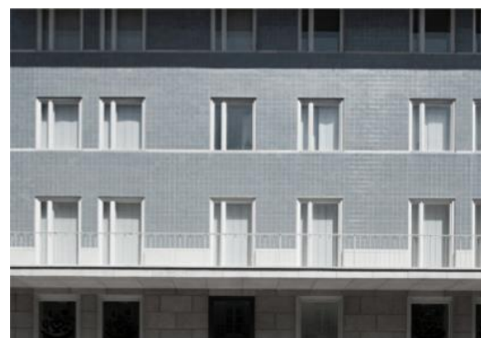
Figura 15. Fachada dos Terraços de Bragança para a Rua do Alecrim. (Disponível em: www.fontdarquitectura.com )
