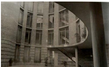
2 Pátio do edifício Doña Coronel. Projecto dos arquitectos Cruz e Ortiz. Sevilha 1976
