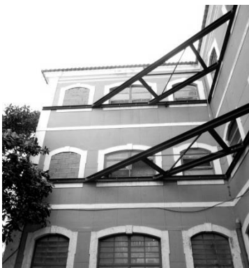
24. Fachada | Rua de S. Boaventura
