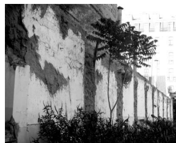
19 Empena que denuncia a antiga estrutura da litografia
