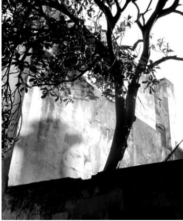
22. Muro da Rua S. Boaventura
