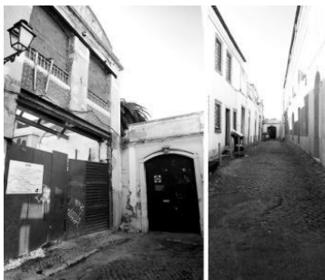
15 Estado atual do Pátio do Tijolo
