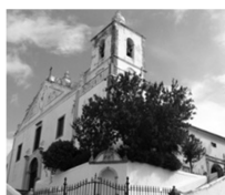
Figura 18 – Igreja de São Sebastião
