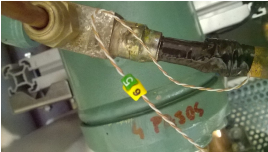
Fig. 99 – Termoparell a la sortida del condensador.
