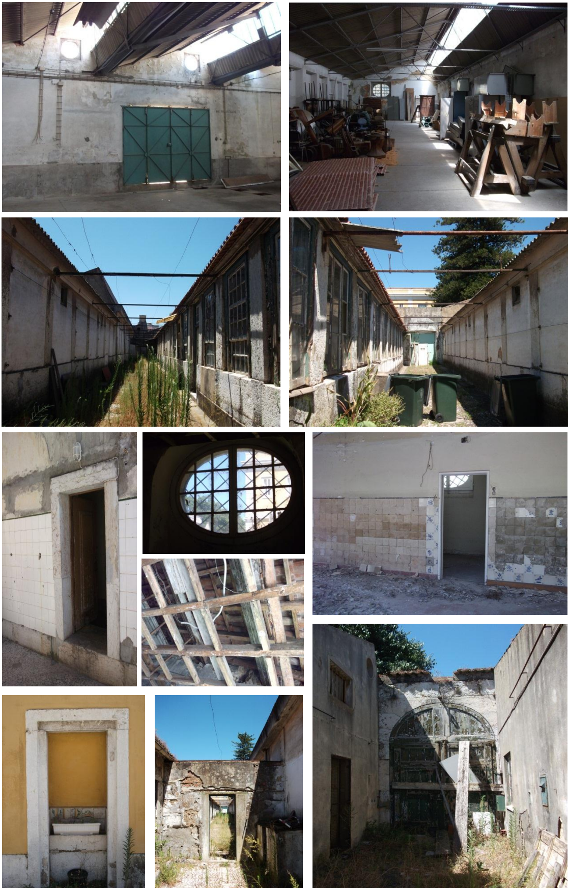
Conjunto de figuras 19: Interior da Cordoaria. Galpões e antiga Creche. Fonte: Fotografias da autora.
