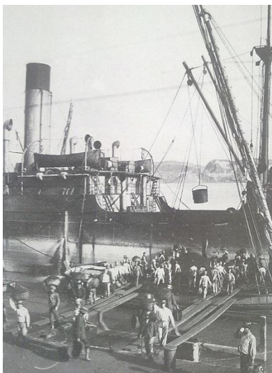
Figura 48: Descarga do carvão. Fonte: Arquivo da Fundação EDP, http://wikienergia.com/~edp/ [Consult. 20 Maio 2011].
