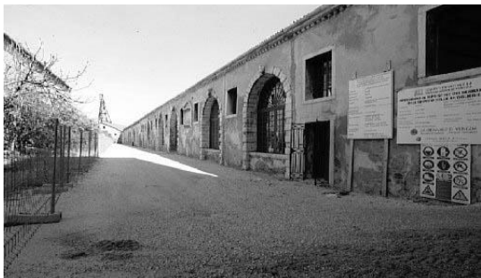
Figura 65: Abandono da Cordoaria. Fonte: Arquivo do Arsenale di Venezia spa http://www.arsenaledivenezia.it [Consult. 27 Maio 2011].
