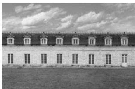
Figura 56: Fachada do lado do rio. Fonte: Service Historique de la Marine de Rochefort http://www.ordiecole.com/cordages.pdf [Consult. 20 Maio 2011].
