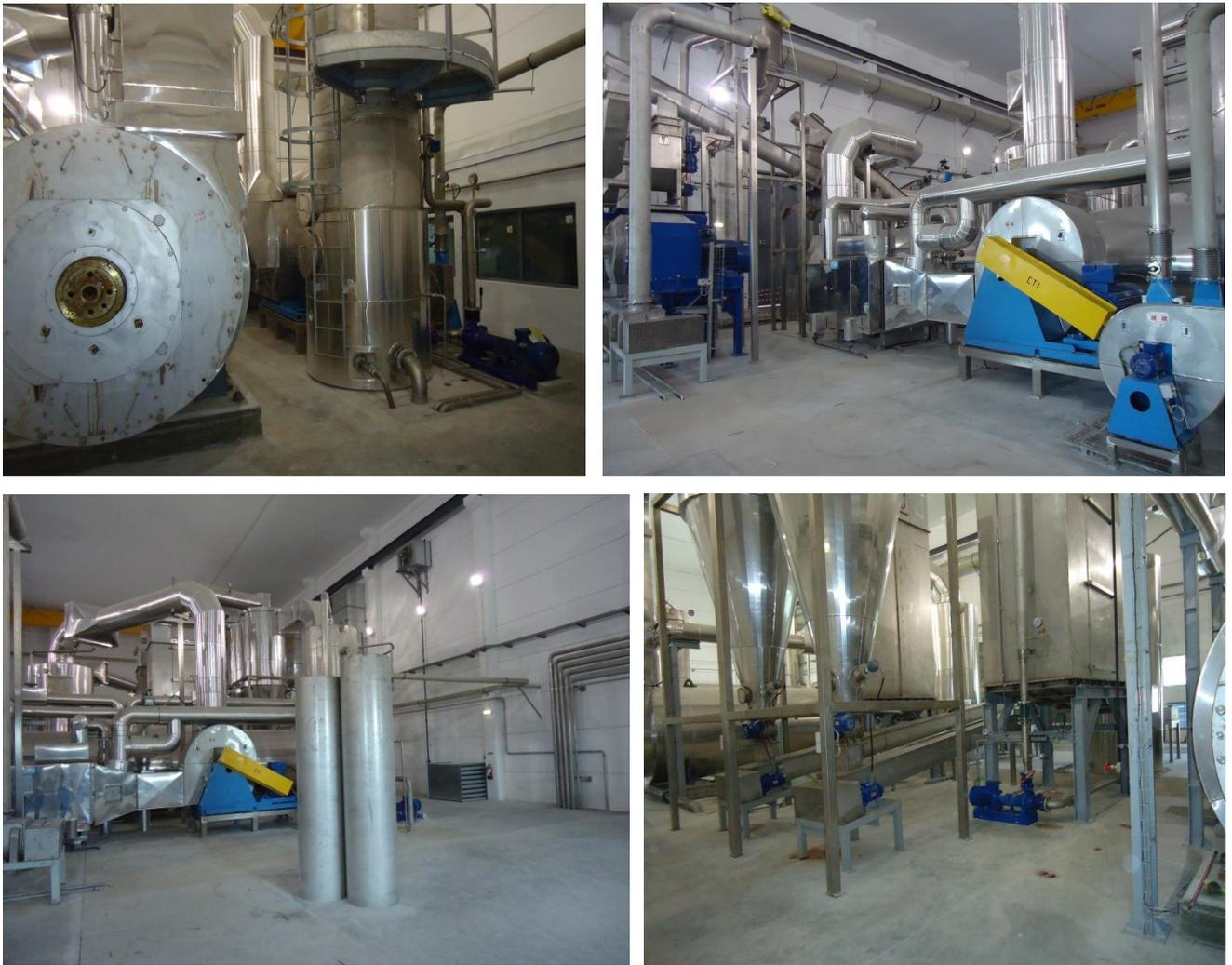
**Figura 4-7 Instalação integral do Turbo-Secador VOMM (Fonte: Cortesia ETAR da Guia)**
