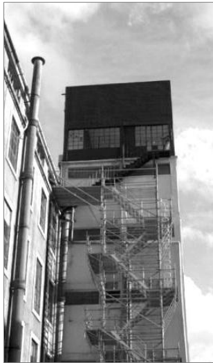
Imagem 7: Red Bull House of Art, depósito de água da LX Factory reconvertido. Créditos: Pauliana Pimentel, 2011
