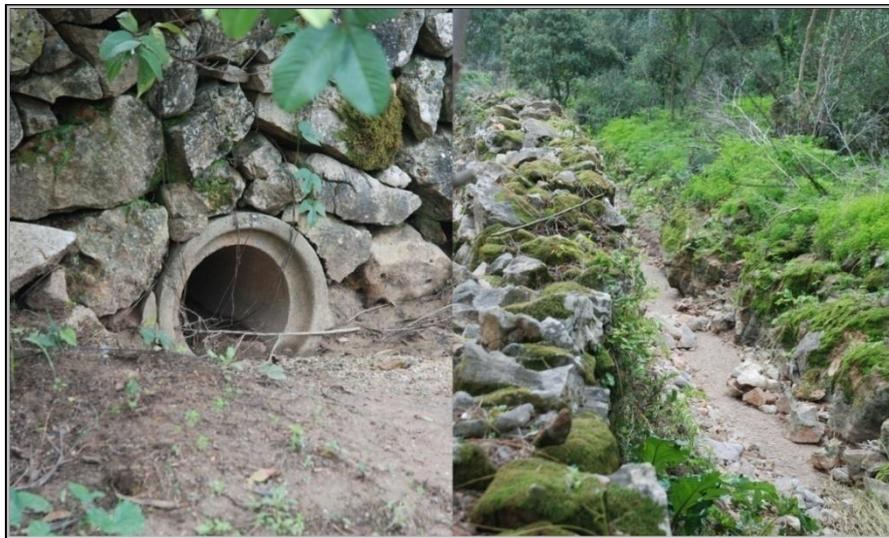
Figura 11 - Muros de Pedra Seca e de contenção da Ribeira; Fonte: Autora
