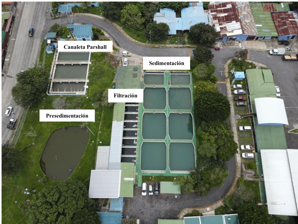
Fig. 2.6. Planta Potabilizadora AyA Guadalupe, Goicoechea, San José.
